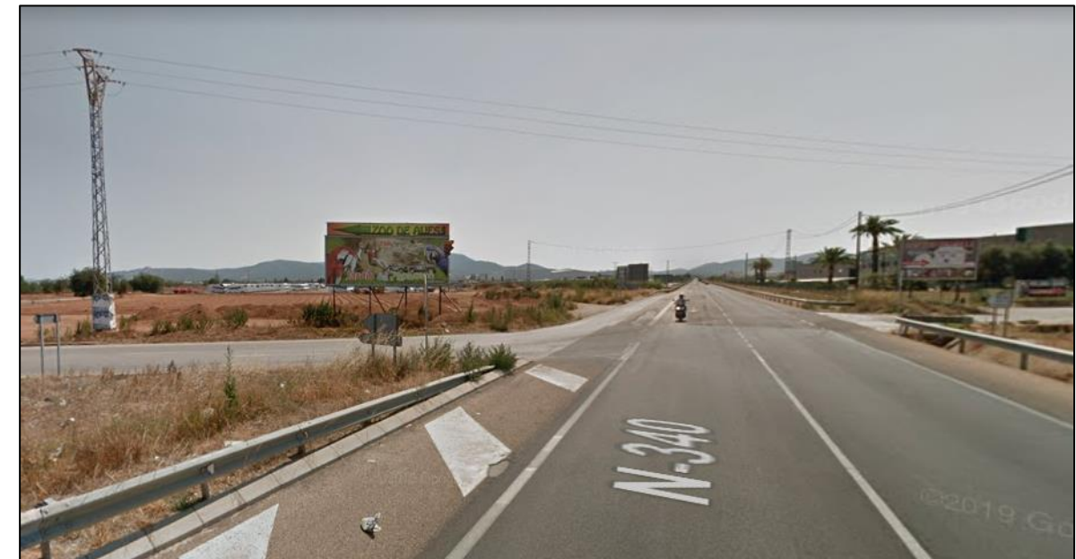
Figura 2.2.1.1. Emplazamiento de la glorieta principal, en el cruce de la Nacional y el camino. Se aprecian elementos como vegetación, un panel publicitario, guardarraíles, bordillos y otros elementos que deberán ser retirados antes de empezar con la construcción de la glorieta. Fuente: Google Maps.
