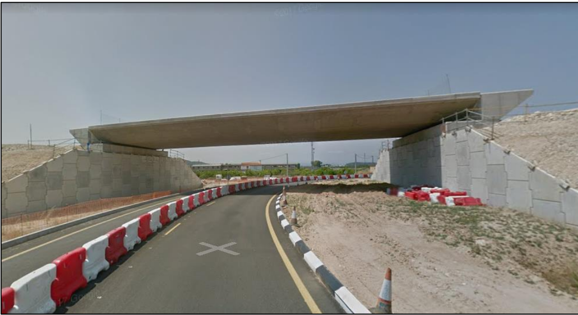
Figura 3.1.1. Tablero del puente ya ejecutado sobre estribos en las obras de la glorieta a distinto nivel en el PK 1044 de la N-340. Fuente: Google Maps.
