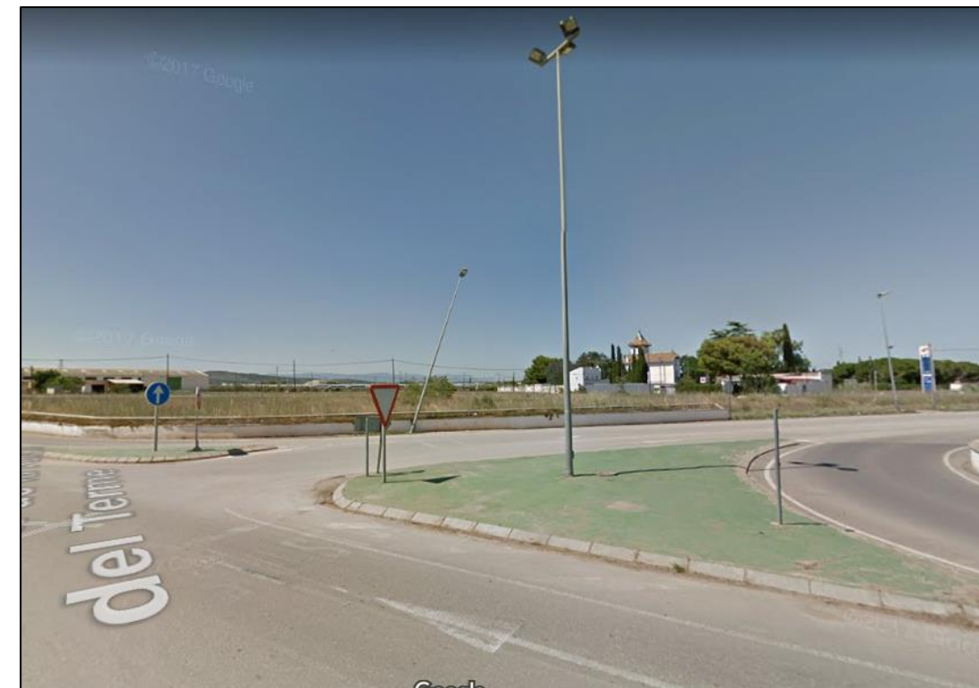
Figura 2.2.1.2. Emplazamiento de la glorieta secundaria, que sustituye la actual intersección en T y da acceso al centro comercial. En este caso deberá retirarse la isleta separadora, además de bordillos, vegetación, elementos de iluminación, etc. Fuente: Google Maps.
