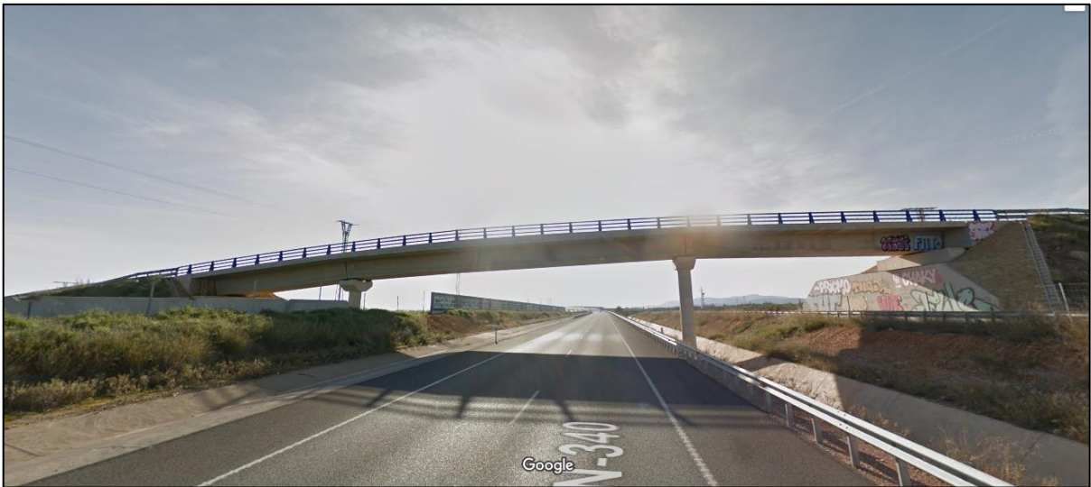
Figura 4.2.3.1. Puente isostático con viga en cajón sobre el P.K. 1046+400 de la N-340. Vano de 25 m entre pilas. Fuente: Google Maps.
