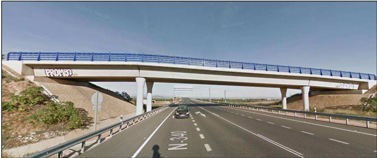
Figura 4.2.3.2. Puente isostático con doble viga en artesa sobre el P.K. 1039 de la N-340. Vano de 24 m entre pilas. Fuente: Google Maps.
