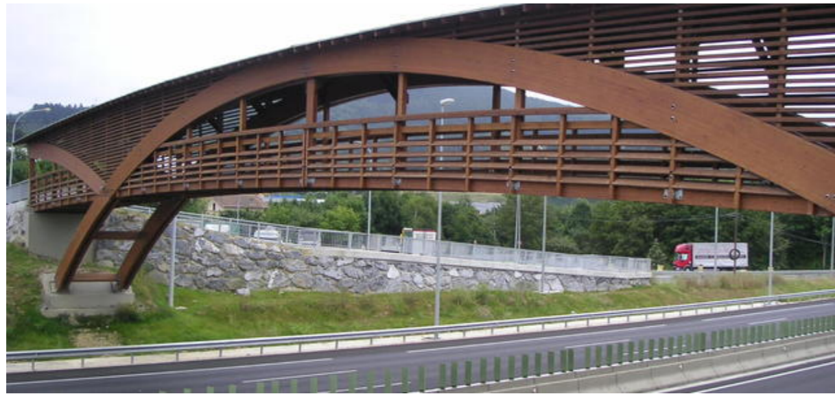
Ilustración 6. Pasarela de madera con arcos triarticulados con cubierta, de 60 metros de luz en Vizcaya, similar al propuesto en el presente proyecto básico. (Fuente: www.mediamadera.com )
