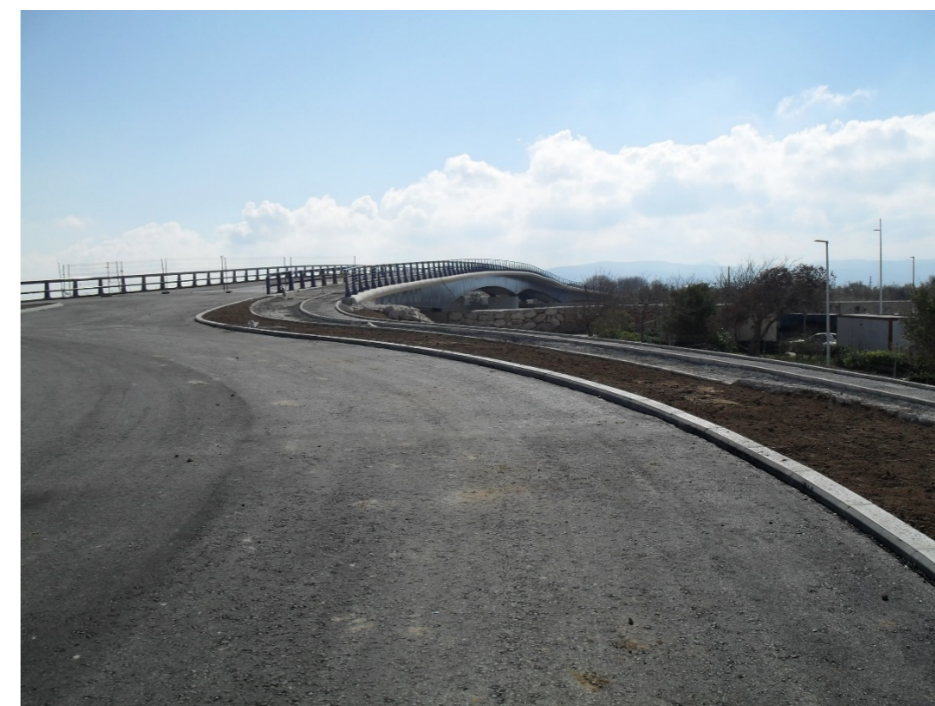
Ilustración 1. Fotografía del puente actual desde la rotonda en la margen izquierda del río Serpis. Se aprecian los diferentes carriles para cada tipo de circulación (Fuente: Propia)
