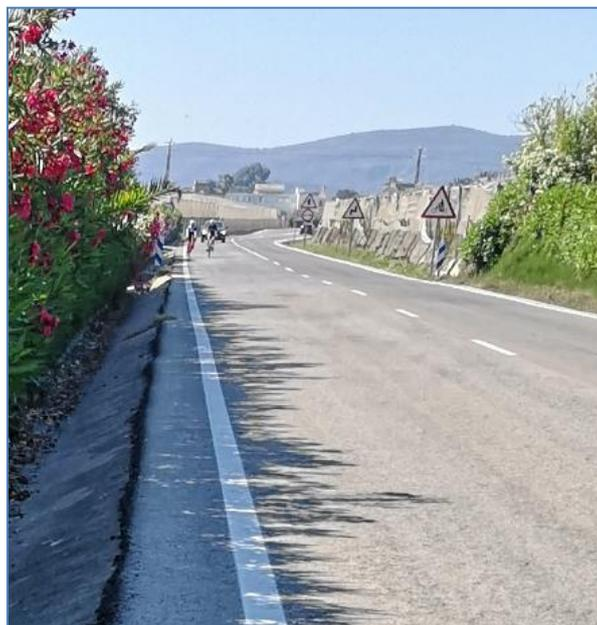
**Figura 130. Ciclistas circulando por la calzada debido a la escasez de arcén**
