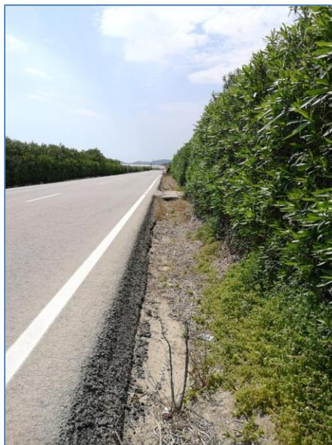
**Figura 71. Desniveles existentes en los márgenes de la plataforma**
