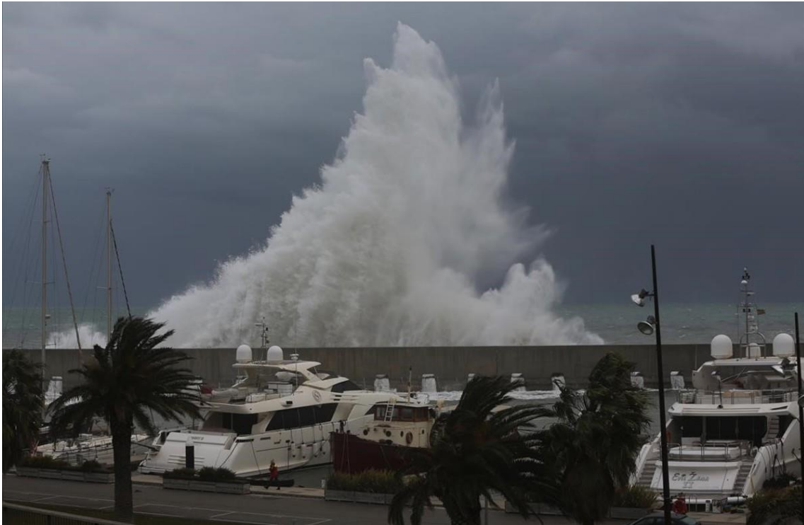
Figura 6. Rebase en Port Fòrum.
