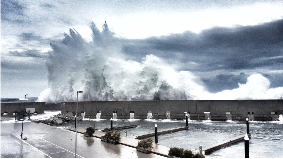
Figura 7. Rebase en Port Fòrum.
