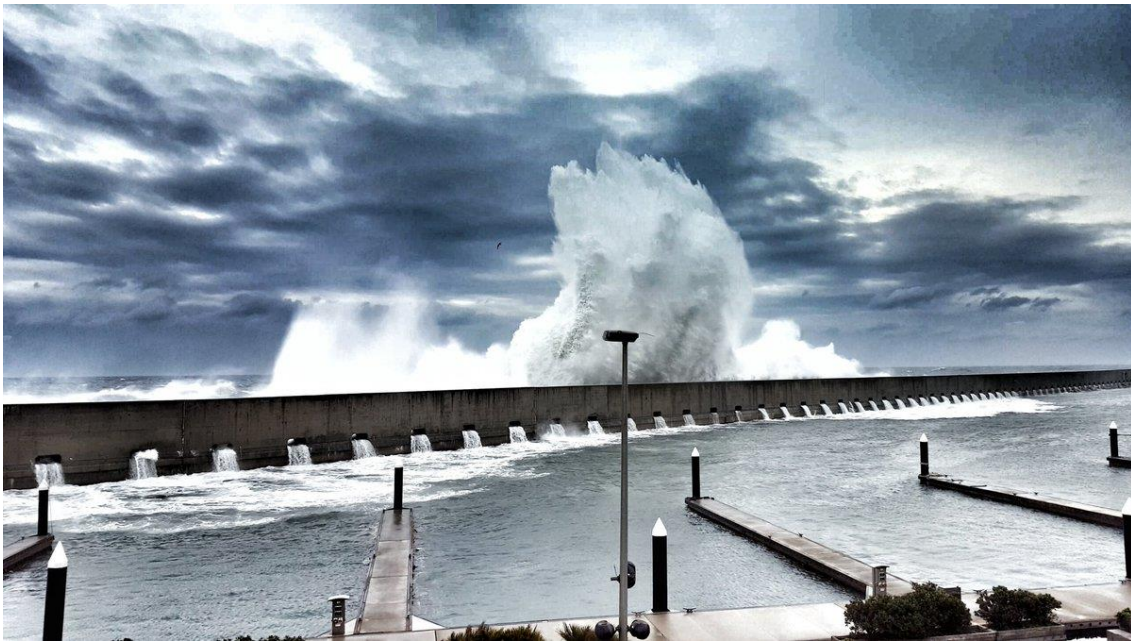
Figura 8. Rebase en Port Fòrum.
