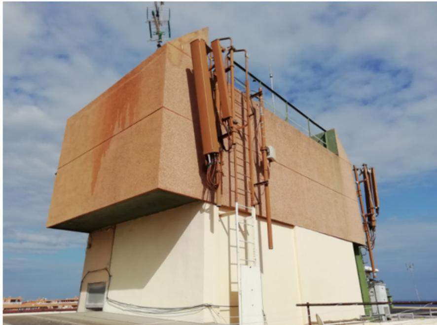
Figura 5.7: Sistema radiante sector 2 Y 3
