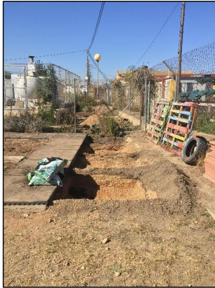
Figura 15. Bancal 4 con 30cm de suelo retirado.
