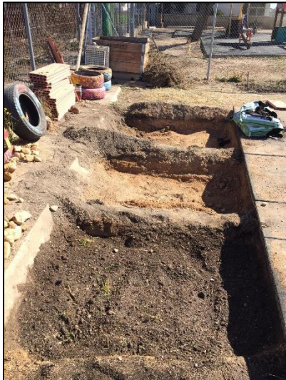
Figura 16. Bancal 4.3 con suelo abonado.
