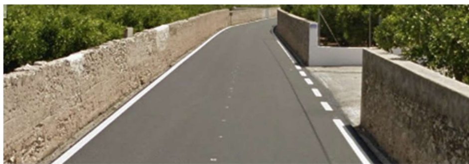
Figura 59. Incumplimiento de visibilidad necesaria en el P.K 0+910. (Google Earth)
