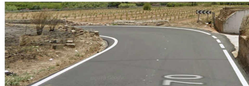
Figura 61. Incumplimiento de visibilidad necesaria en el P.K 0+1720. (Google Earth)
