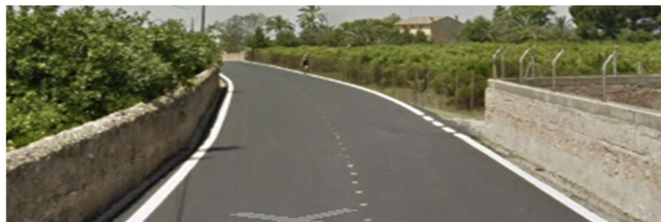
Figura 58. Incumplimiento de visibilidad necesaria en el P.K 0+500. (Google Earth)
