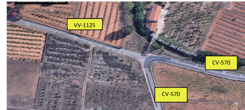
Figura 15. Intersección nº2 de la CV-570. (Google Maps)
