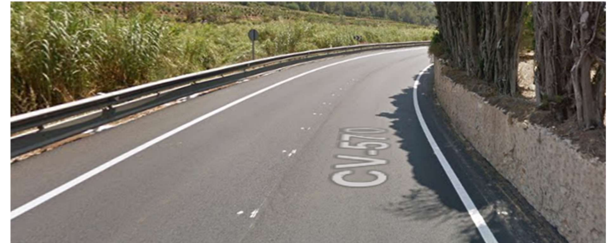
Figura 8. Fotografía Tramo IV (Google Maps)
