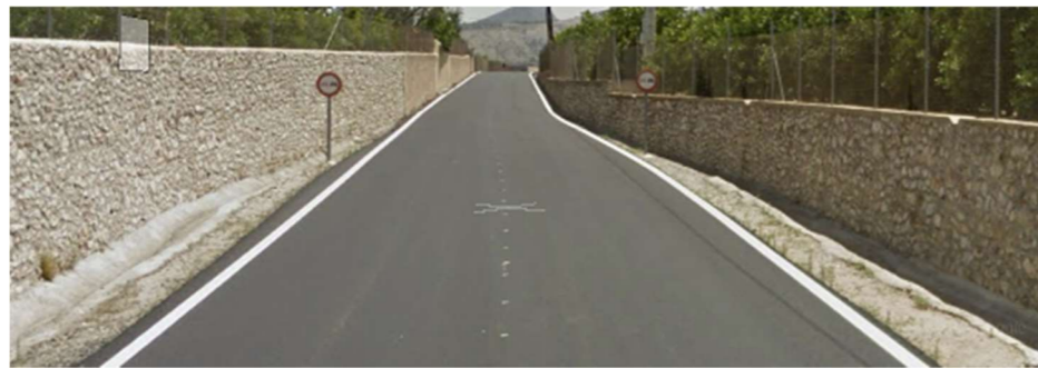
Figura 57. Incumplimiento de visibilidad necesaria en el P.K 0+380. (Google Earth)
