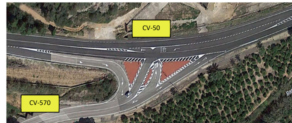
Figura 16. Intersección nº3 de la CV-570. (Google Maps)
