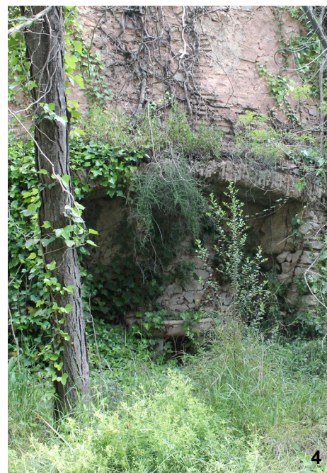
Fig. 3. Estado actual del interior del casón residencial de la alquería de Cotalba.
