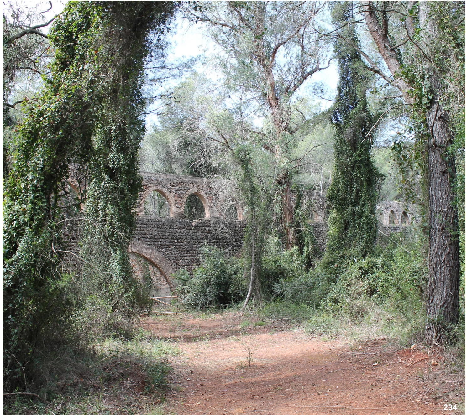
Fig. 234. Estado actual del espacio visitable del acueducto.
