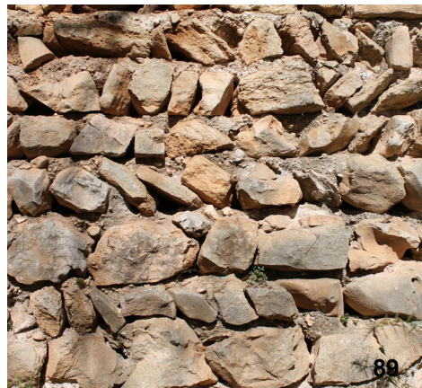
Fig. 89. Muro entre el volumen (2) y (3) de los corrales, de mampostería regular en opus spicatum (M10).
