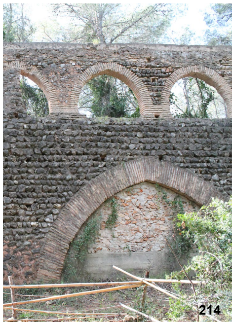
Fig. 215. Detalle de las tongadas horizontales que conforman la estructura del acueducto.
