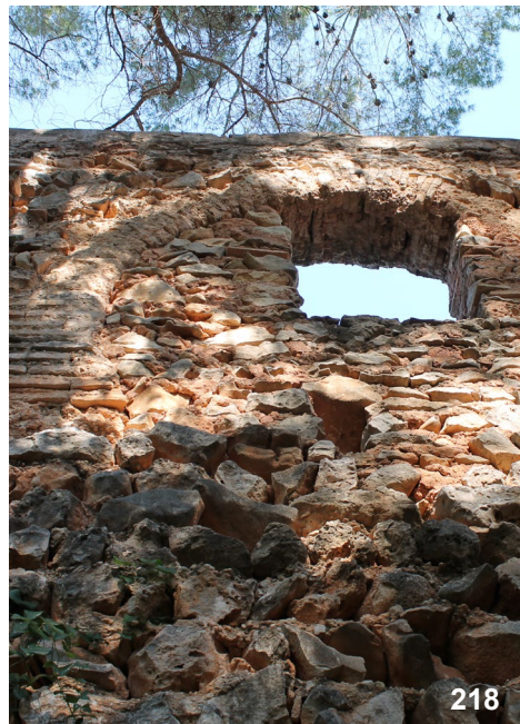
Fig. 218. Detalle de uno de los arcos del tramo superior del acueducto.
