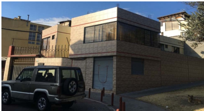
Imagen # 40 Construcción existente donde se ubicara el proyecto - Fuente: Autoría propia
