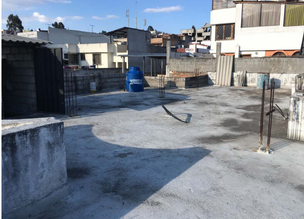
Imagen # 41 Construcción existente del proyecto / 3er nivel - Fuente: Autoría propia
