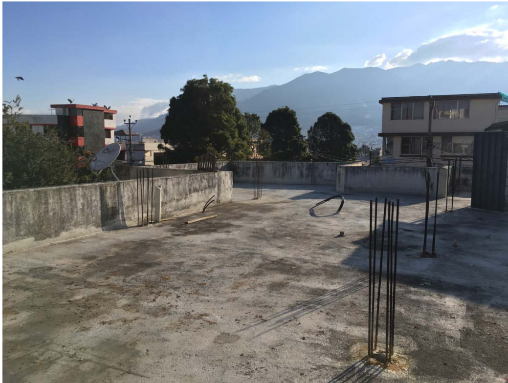
Imagen # 42 Construcción existente del proyecto / 3er nivel - Fuente: Autoría propia
