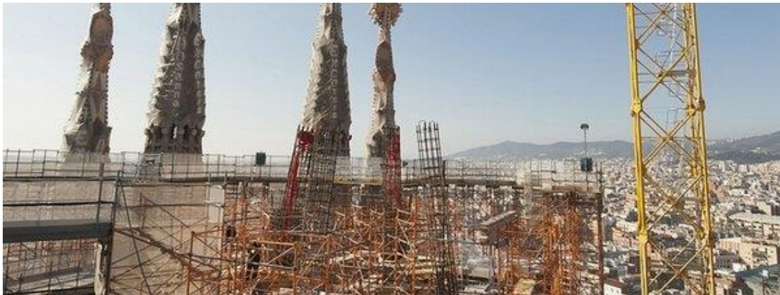
Figure 13. Sagrada Família construction works. Sagrada Família archive, 2015.
