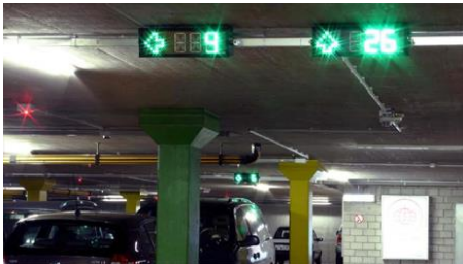
Ilustración 2. Ejemplo de Sistema Guiado de Aparcamiento. Fuente: Omnitec Group
