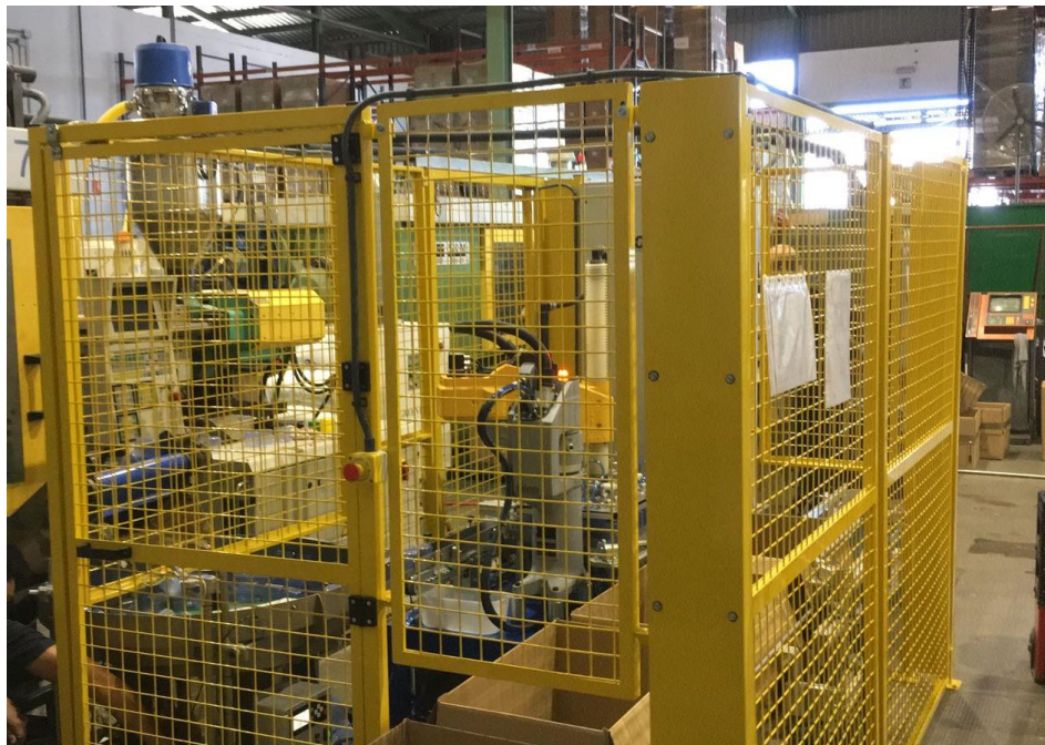
Imagen 36 Vallado de seguridad
