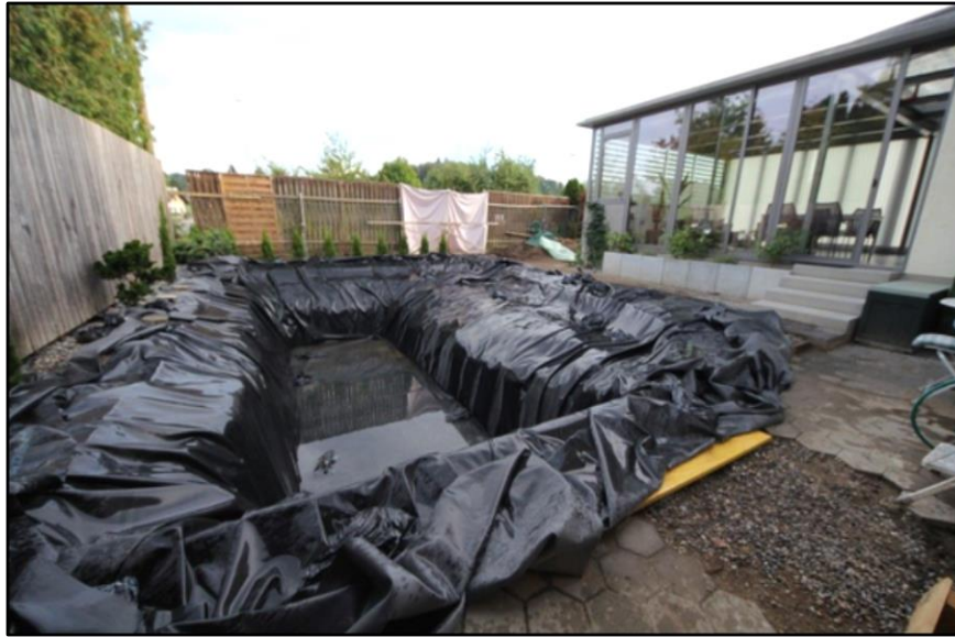
Figura 39. Colocación lamina impermeable en vaso piscina. 2019. https://www.numaniaticos.com
