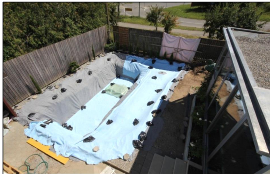
Figura 38. Colocación geotextil. 2019. https://www.numaniaticos.com
