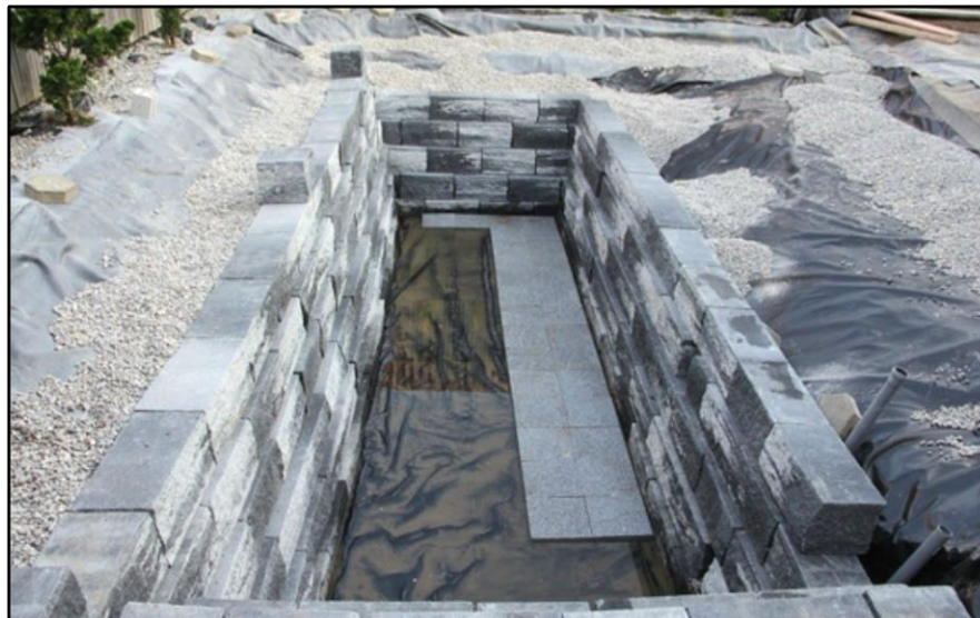
Figura 40. Colocación sillares de piedra en vaso piscina. 2019. https://www.numaniaticos.com
