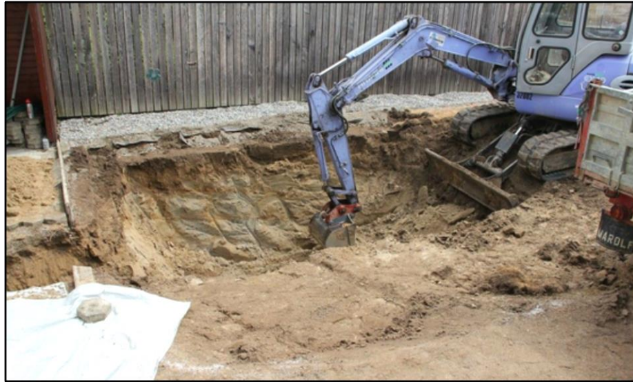
Figura 37. Excavación baso piscina. 2019. https://www.numaniaticos.com
