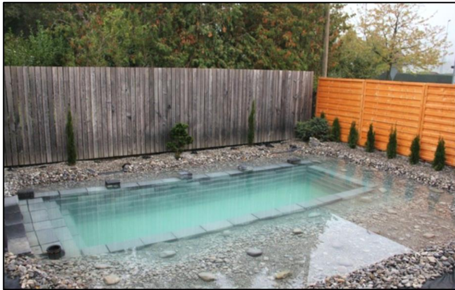
Figura 41. Grava colocada zona de filtrado. 2019. https://www.numaniaticos.com
