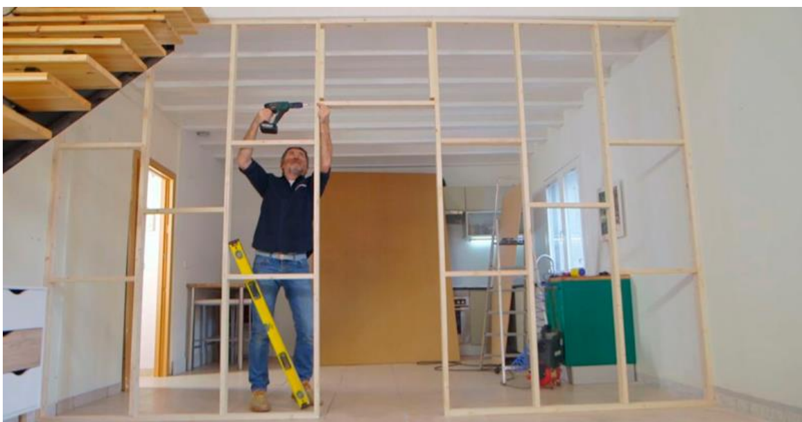
Figura 52. Estructura de madera para particiones interiores. 2019. https://www.venturelli.cl
