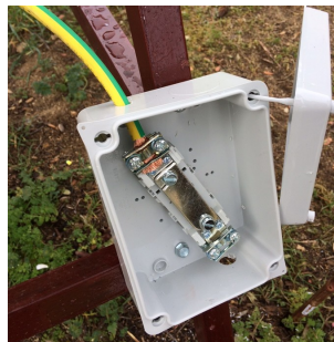
Figura 19: Toma de terra. Recuperada de: https://es.habcdn.com/photos/project/big/toma-tierra-independiente-1438823.jpg?
