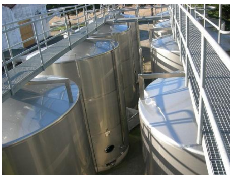
Figura 6.25. Barandilla en línea superior de las cisternas o depósitos.
