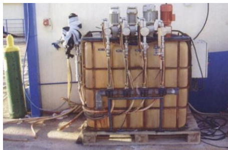
Figura 6.8. Dosificador de SO 2 .
