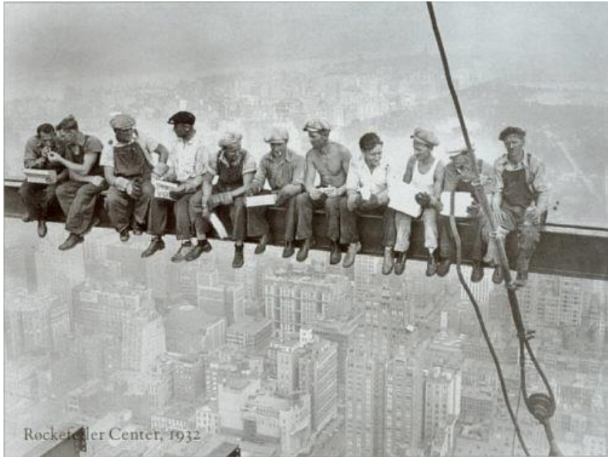
Ilustración 2 Construcción Rockefeller center. Fuente: https://www.flickr.com/photos/eggpoint/6143475184
