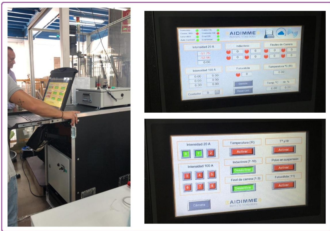
Figura 6.2: Pruebas armario rack.
