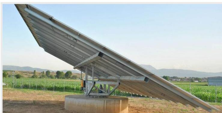
Ilustración 35. Ejemplo del tamaño de la cimentación requerida para seguidor de eje vertical. (Fuente: "MECA SOLAR").
