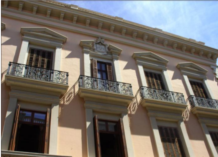
Fig. 57 Parte superior de la fachada. Fuente: foto de autor.
