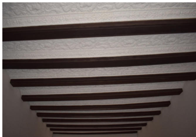
Fig. 73 Tramo entrevigado de acceso al edificio por la puerta nº 22. Fuente: Fotos de autor.
