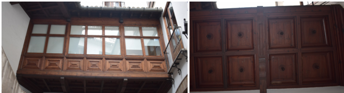
Fig. 77 y 78 Galería de madera. Fuente: Fotos de autor.
