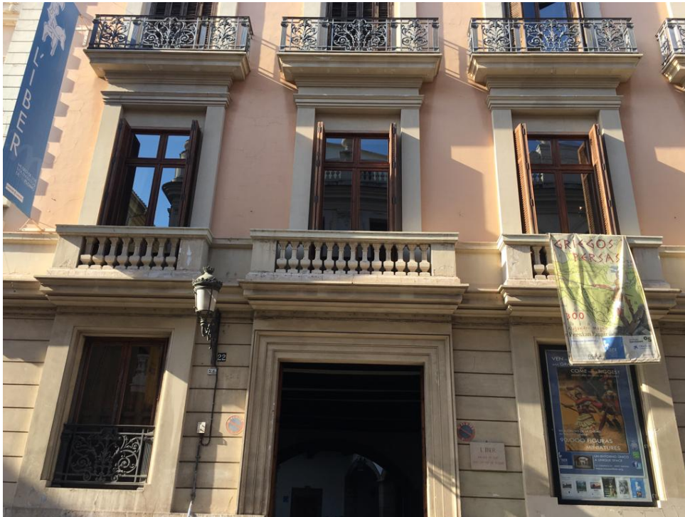
Fig. 50 Detalle de las puertas de acceso. Fuente: foto de autor
