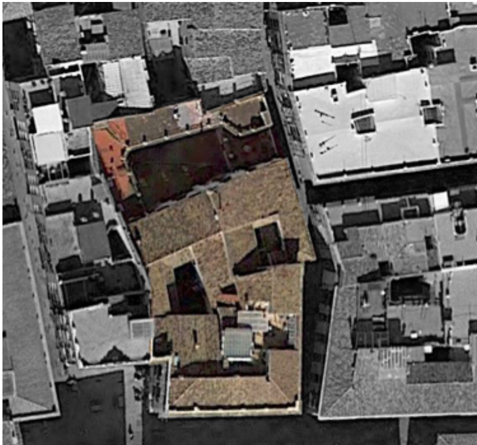
Fig. 9 Calles colindantes al Palacio del Marqués de Malferit. Fuente Google Maps
