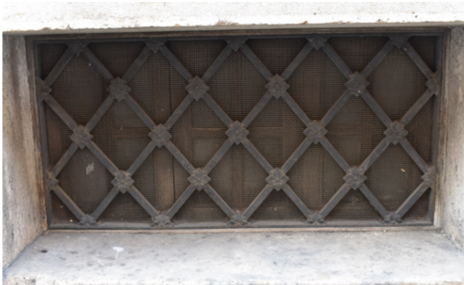
Fig. 24 Vano rectangular enrejado del semisótano del Palacio del Marqués de Malferit. Fuente: Foto de autor
