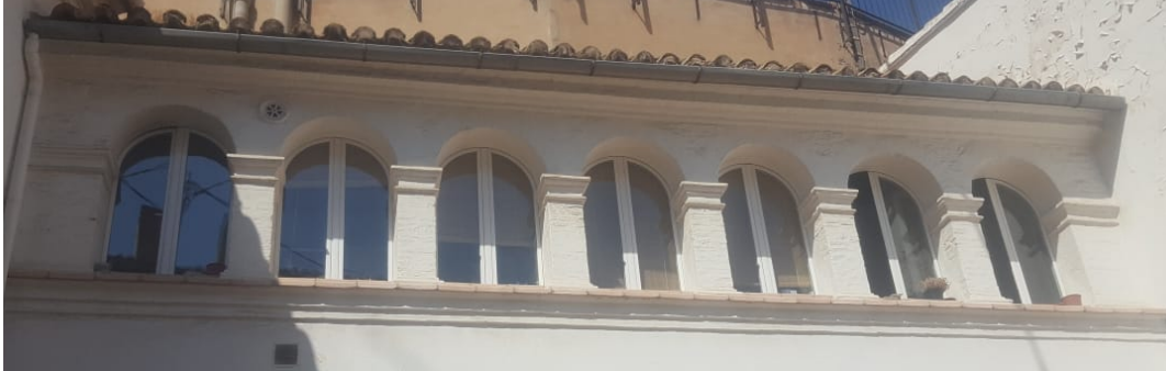
Fig. 83 Galería de arcos de medio punto. Fuente: Fotos de autor.
