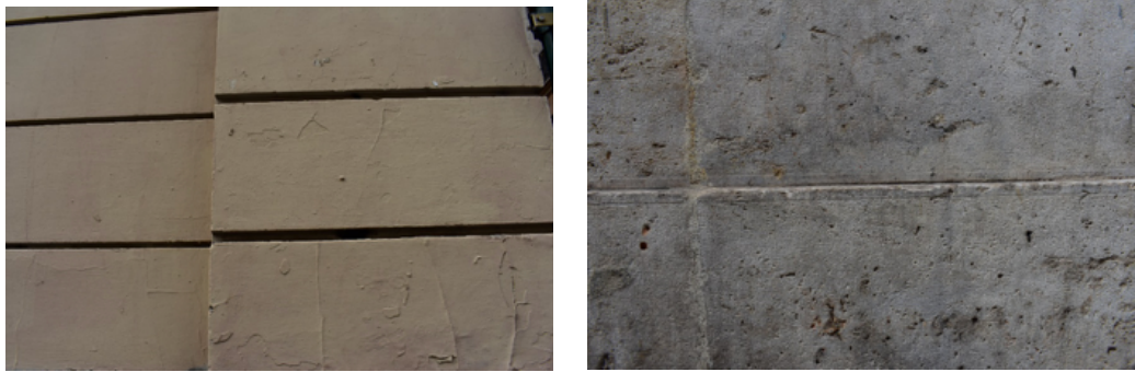
Fig. 66 y 67 Revestimientos exteriores del edificio. Fuente: foto de autor.
