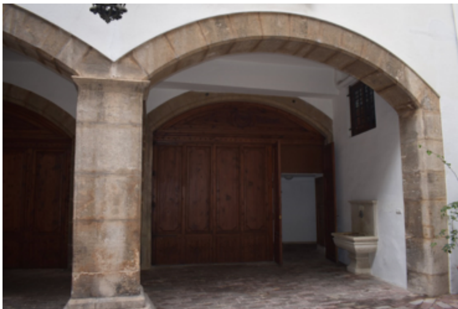
Fig. 85 Arcos escarzanos sustentados por un pilar en sección en cruz. Fuente: Fotos de autor.
