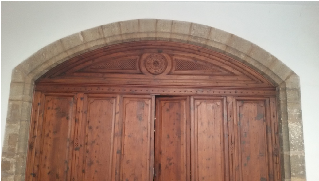
Fig. 86 Antiguas caballerizas. Fuente: Fotos de autor.
