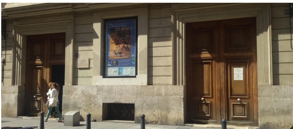
Fig. 49 Puertas de acceso al edificio. Fuente: foto de autor
