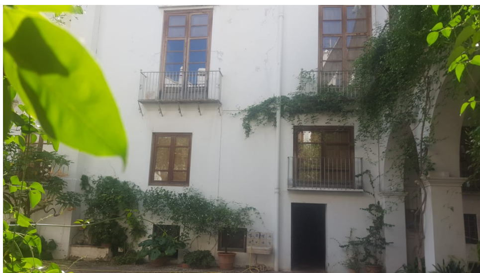
Fig. 89 Patio de los Arcos. Fuente: Fotos de autor.
