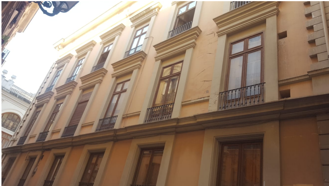
Fig. 21 Fachada recayente a la calle Mare Vella
