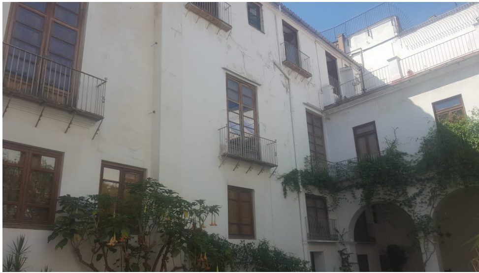
Fig. 88 Fachada del patio interior o jardín. Fuente: Fotos de autor.
