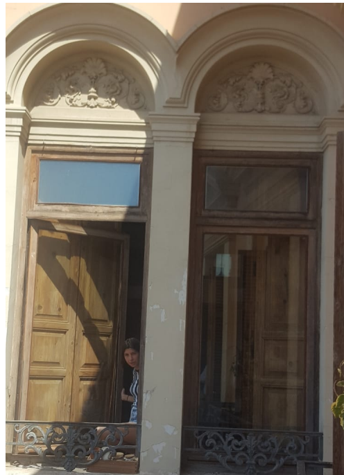
Fig. 63 Ventana que da la Plaza Conde de Bueñol. Fuente: Foto de autor
