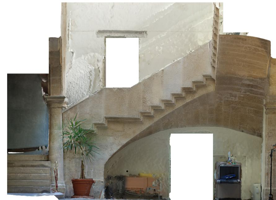
Figura 35\_ Alzado obtenido mediante el programa de Photocan
