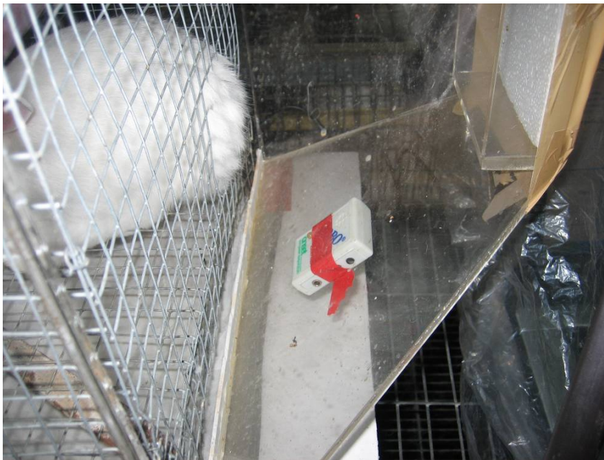
Figura 39. Detalle de la localización de la sonda de T a y HR en el interior de la cámara
