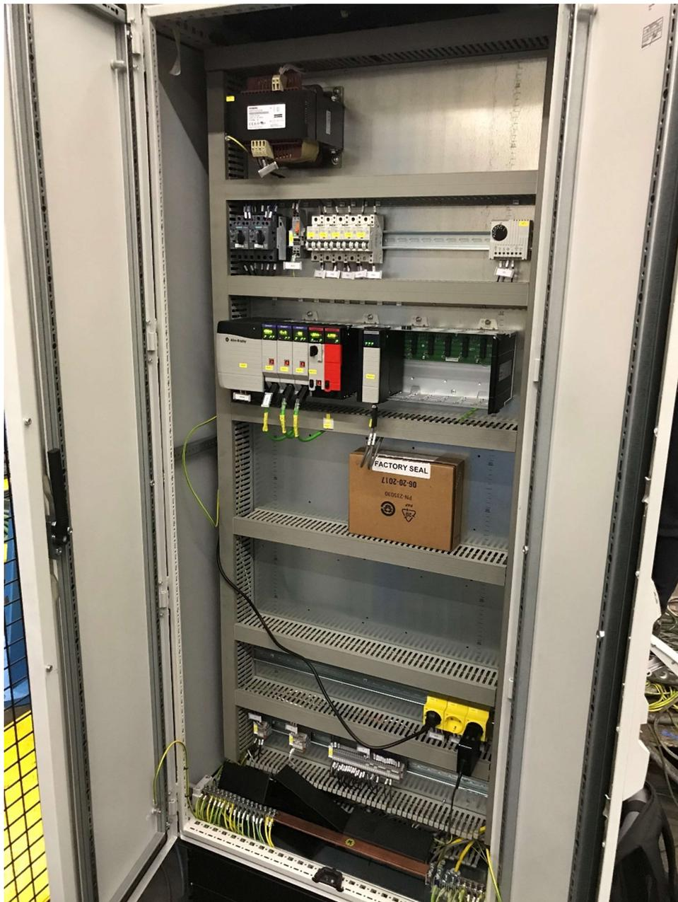
**Ilustración 10. Chasis del PLC ubicado en la parte posterior del PC de línea [6]**
