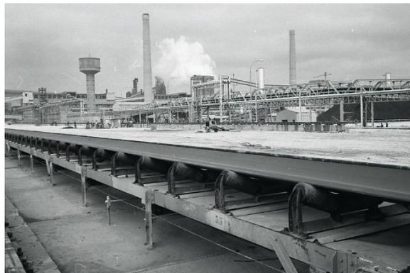
*Ilustración 1 Cinta transportadora de carbón*
