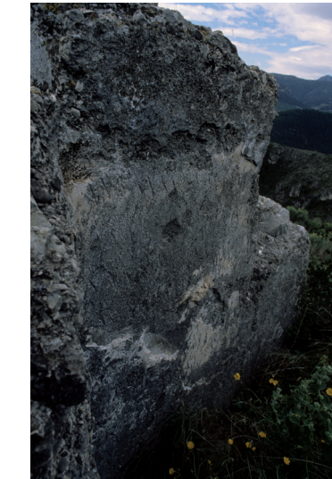
Llenç del castell de Borró, amb la característica "espina de peix" per a adherir els arrebossats de morter de calç. Foto: Josep A. Gisbert.
