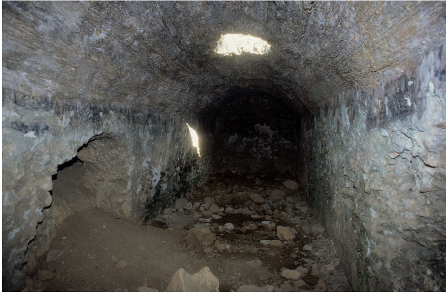
Gran aljub, cobert amb volta amb el característic encofrat amb empremtes de canyís. Segle XII. Castell de Vilallonga. Foto: Josep A. Gisbert
