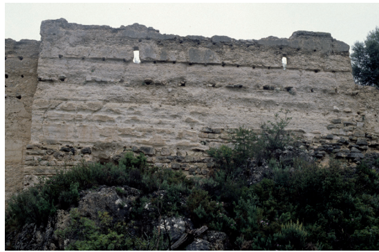
Torre del recinte del castell de Vilella, amb línia d'espitlleres. Foto: Josep A. Gisbert.
