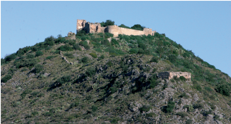
Castell de Bairén. Al primer plànol, torre quadrada, que protegeix l'angle del recinte de la Medina. Foto: Josep A. Gisbert.
