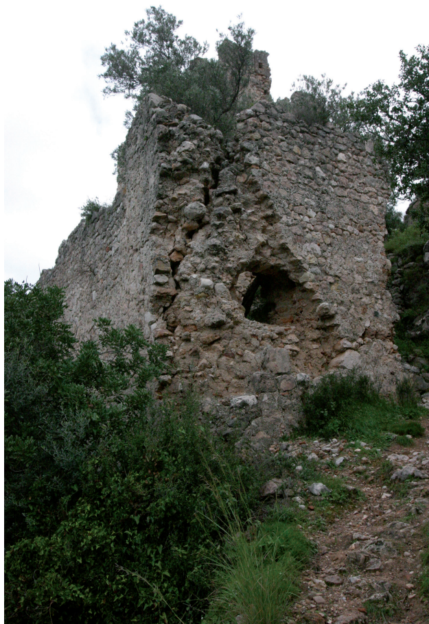
Esquerdas al castell de Rebollet. Emprems del terratrèmol que, a les darreries del segle XVI, provocà la runa de part de les arquitectures. Foto: Josep A. Gisbert.
