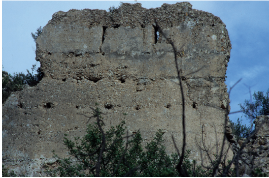
Llenç de tàpia del castell de Vilallonga amb línia d'espitlles. Foto: Josep A. Gisbert.
