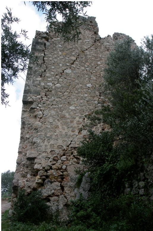
Torre major del castell de Rebollet. Primera meitat del segle XVI. Obra dels comtes d'Oliva. Parament extern de pedra i carreus cadenats als angles. Foto: Josep A. Gisbert.
