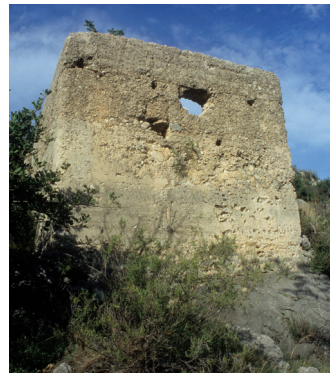
Torre amb murs de tàpia. Castell de Vilallonga. Època almohade. Segle XII. Foto: Josep A. Gisbert.
