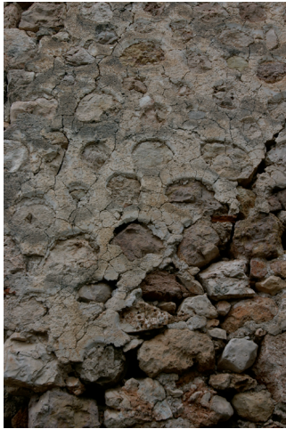
Castell de Rebollet. Torre Major. Detall de l'arrebossat de la torre, que deixa a la vista les cares de les pedres de paredat. Foto: Josep A. Gisbert.
