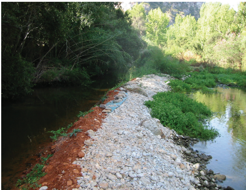
Figura I.3: Modificació del llit original mitjançant la construcció d'una mota lateral (tram1).
