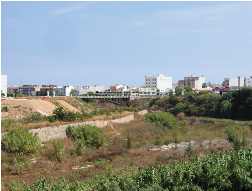
Figura 5.31: Vista aigües avall del punt de mostreig del tram 15.
