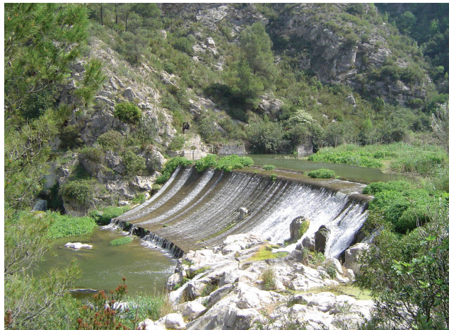
Figura 8.1: Imatge de l'assut de l'Infern on és palesa la necessitat de creació d'un pas per tal de potenciar la mobilitat de la ictiofauna.
