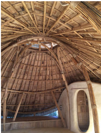
54. Interior de aula
