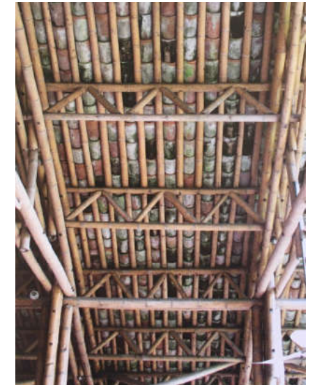
21. Tejas en cubierta de bambú Fuente: Building with bamboo
