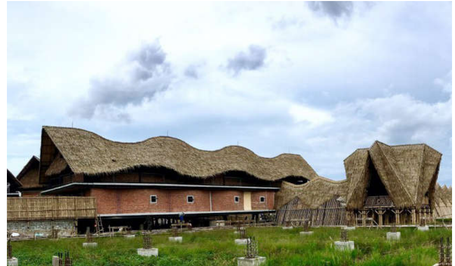
87. Perspectiva de la fachada y la pasarela
