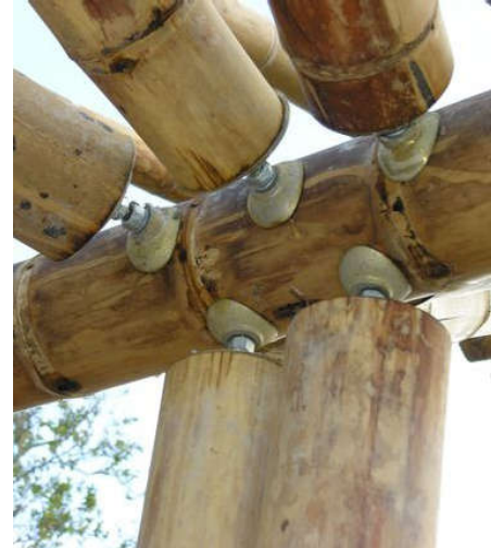
18. Unión atornillada de 6 barras de bambú
