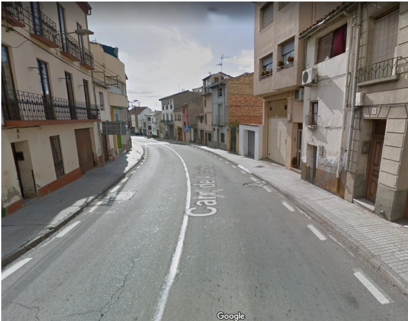
Figura 2 - Vista del tramo de carretera situado en el centro urbano de Híjar.
