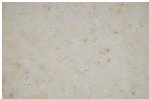
Figura 17 - Detalle de manchas en los revoques calcáreos
