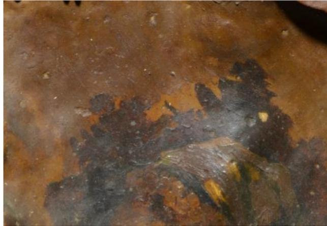
**Figura 125.** Detalle de la cartela con daños mecánicos. Fotografía realizada por el autor de la investigación
