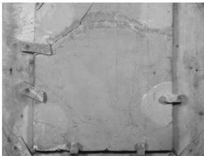
**Figura 74.** Marcas del molde por el reverso de la pieza. Fotografía realizada por el autor de la investigación
