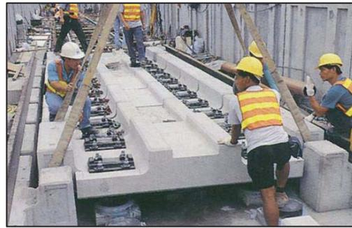
Ilustración 27. Losa flotante sobre apoyos puntuales (PRC Ltd, 2019)
