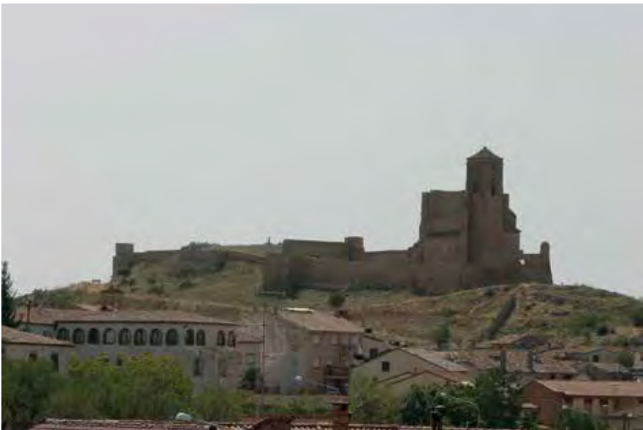
020. Vista de la fortalesa de Benavarri. Fotogr. J.A.G.
