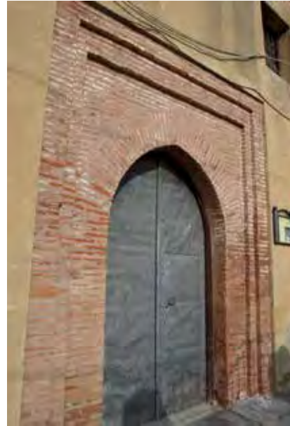
039. Chinchilla. Església del Salvador, després de Sant Julià. Portada de rajola, amb arc ogival i arraba. Fotogr. J.A.G.
