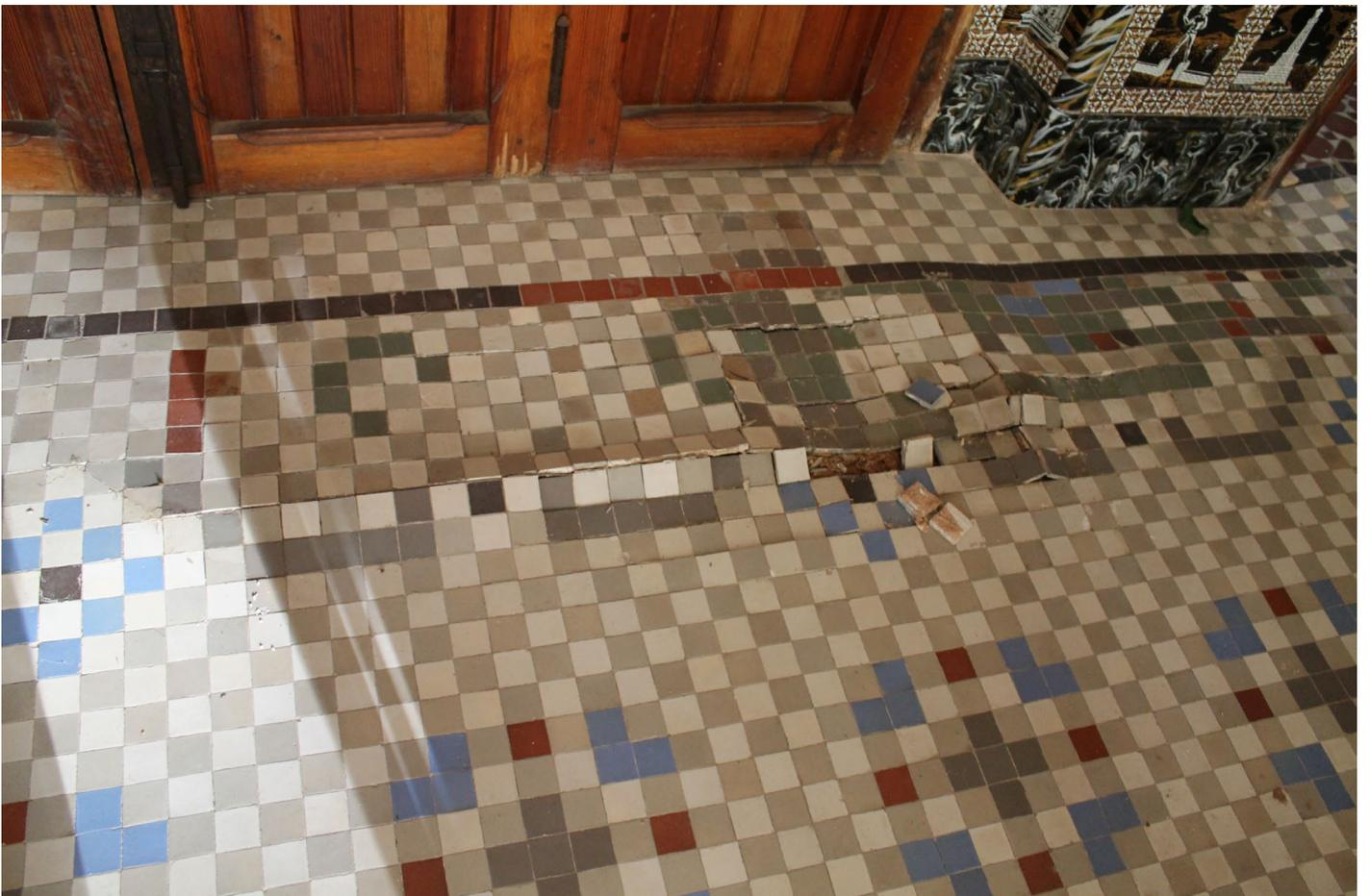
Desplaçament dels taulellets a causa d'un abombament per humetat
