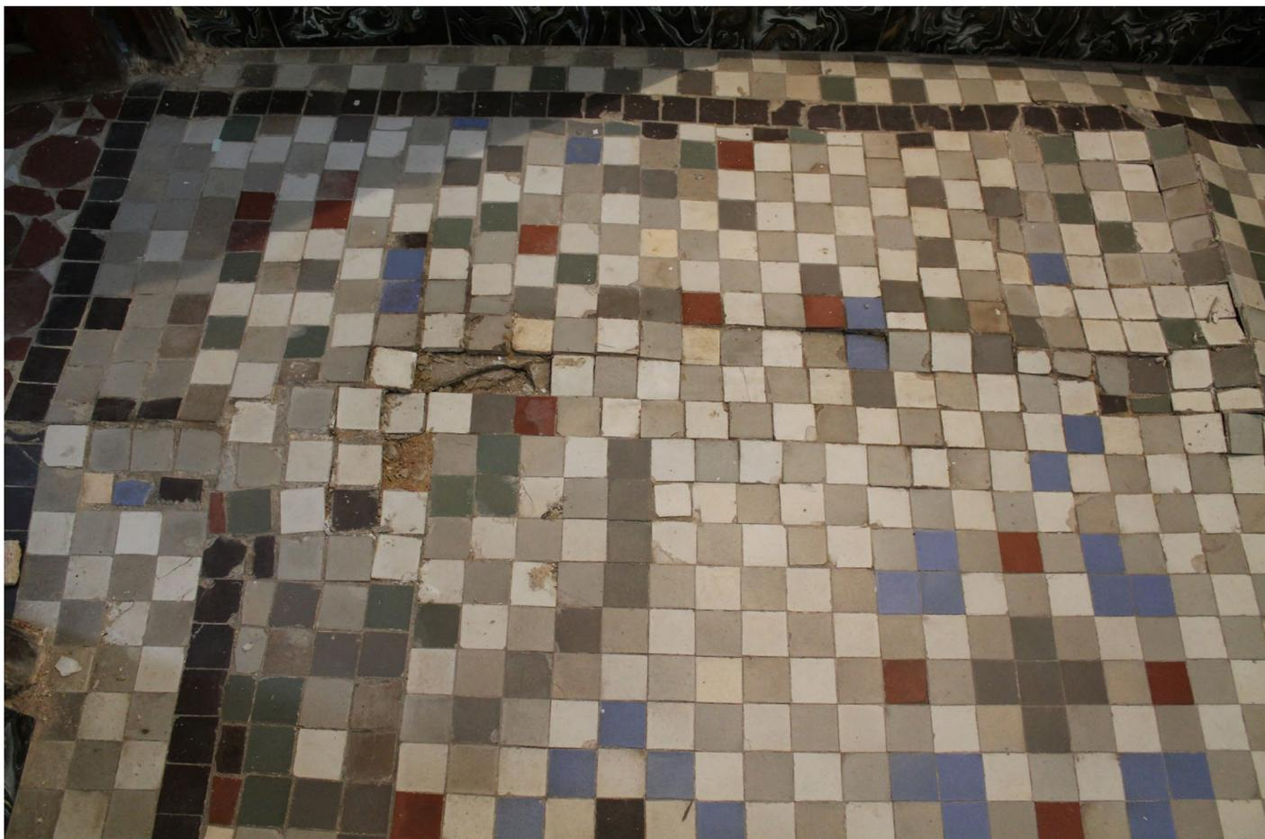
Desplaçamet dels taulellets a causa d'un abombament per humetat
