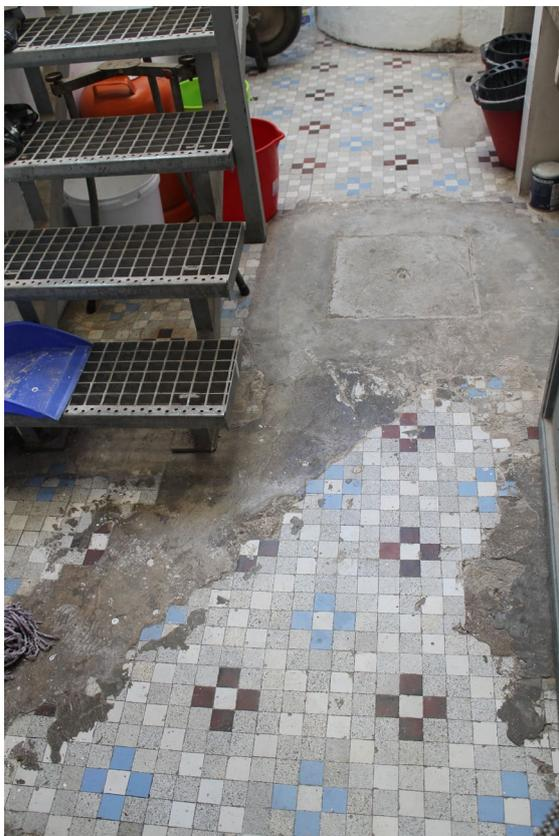
Fig. 169 Reparación realizada con cemento en C/Lledoner, 4
