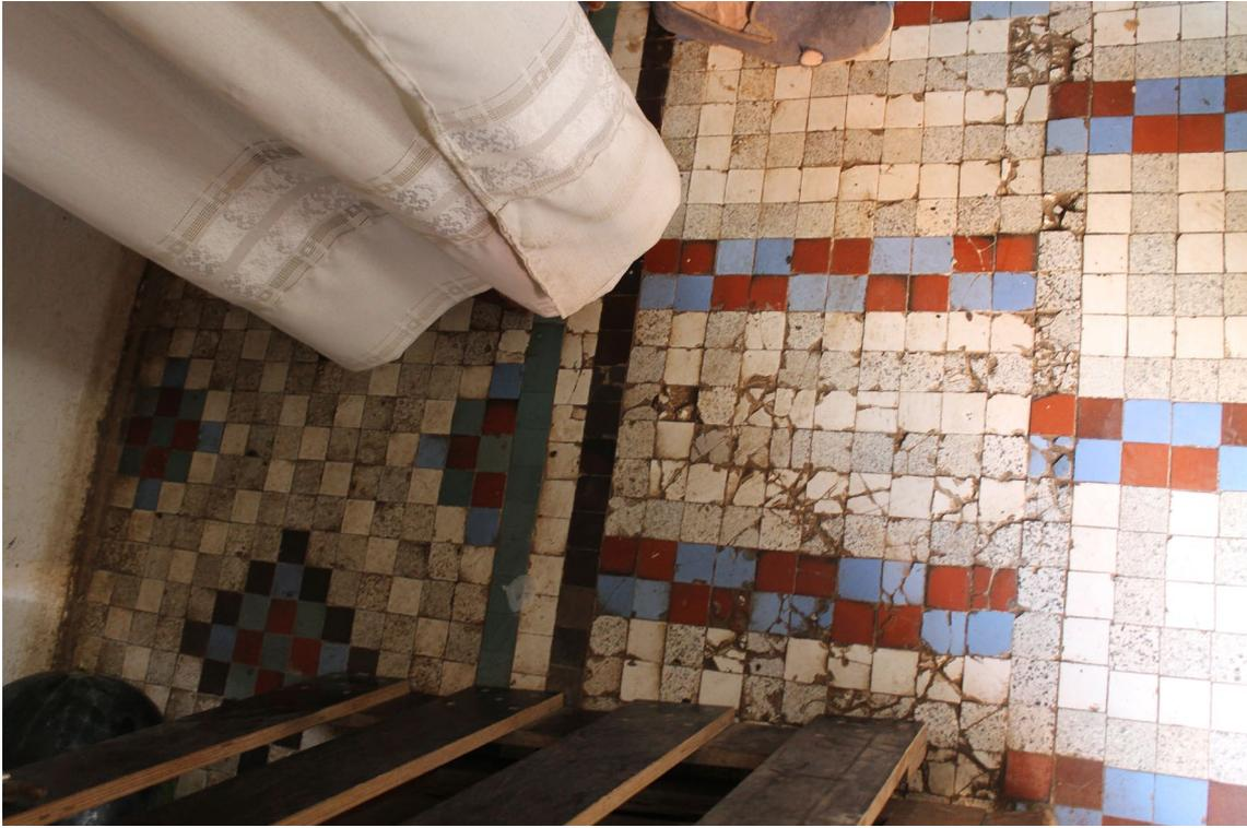
Fig. 162 Ejemplo de rotura de teselas debido al uso en C/Francisco Gil, 13
