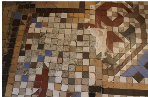
Fig. 168 Reparación con masilla y losetas mal colocadas en C/Lledoner, 44
