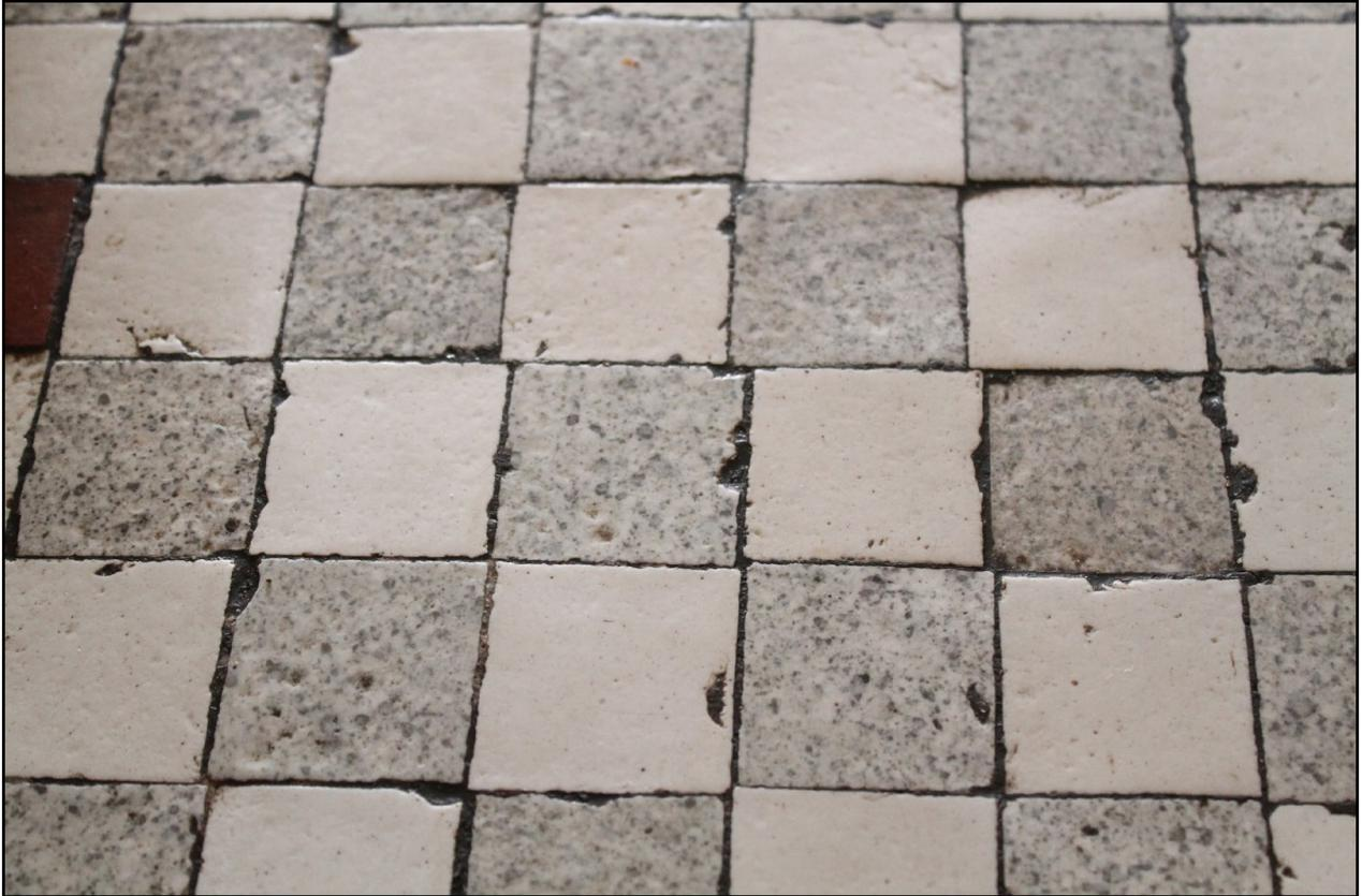
*Imagen 5.* Defectos de producción: deformación de las teselas.
