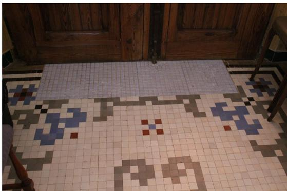
Fig. 167 Reparación realizada con losetas de piscina en Travesera del Calvari, s/n
