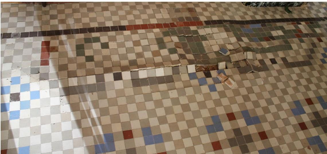
Fig. 161 Ejemplo de abombamiento por humedad capilar con rotura en C/Sant Joan, 23
