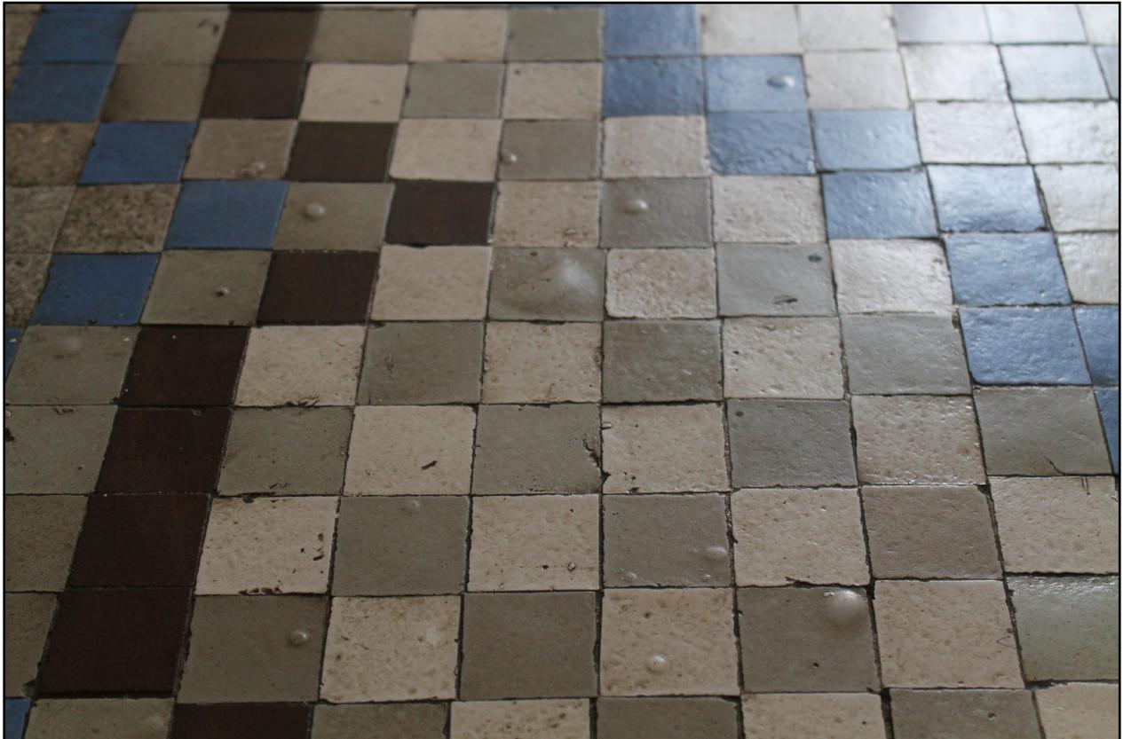
*Imagen 1.* Defectos de producción: burbujas por evaporación
