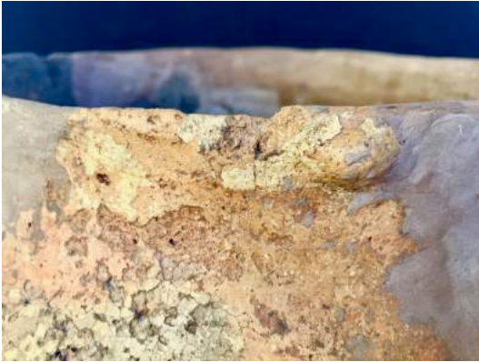
Fig.26. Restos de adhesivo oxidado (goma laca) de antigua consolidación. Archivo SIP.
