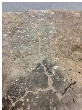
Fig.23. Reintegración de grietas. Archivo SIP.
