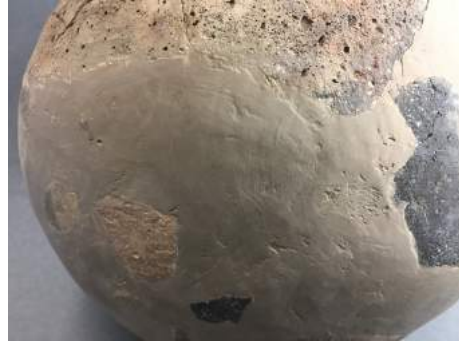
Fig.24. Baja calidad de acabados en los estucos. Archivo SIP.
