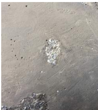
Fig.22. Fragmento original flotando entre el estuco. Archivo SIP.
