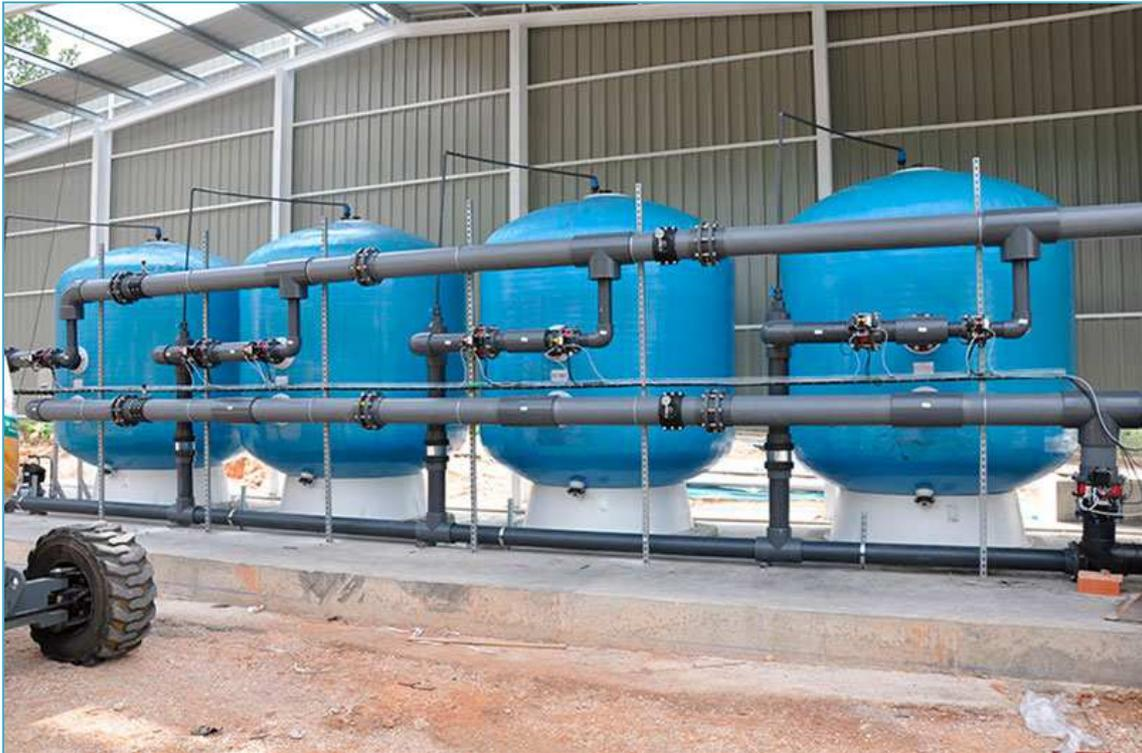
*Fig. 15 Planta de Filtros de Carbón Activo*
