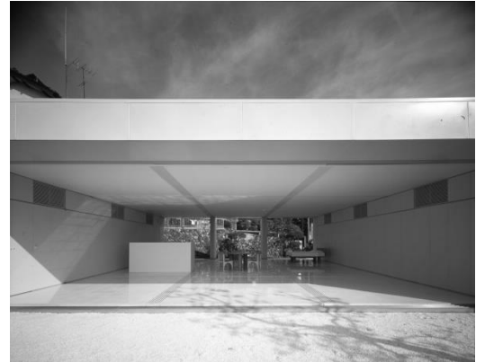
99. Vista exterior de la Casa con una retícula de nueve cuadrados
