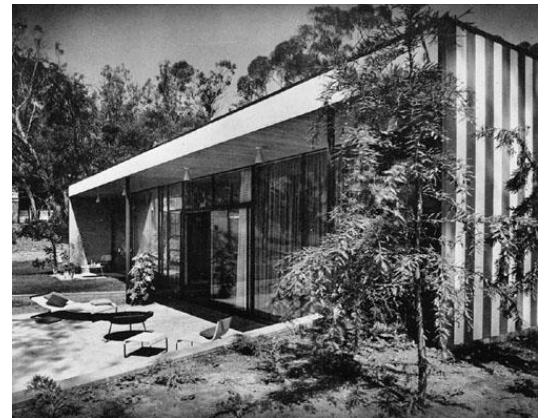
80. Vista exterior de la Casa Entenza
