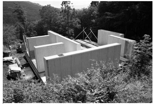
94. Puesta en obra de los módulos de mobiliario
