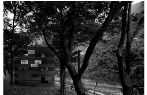
40. Vista exterior de la Casa de madera definitiva
