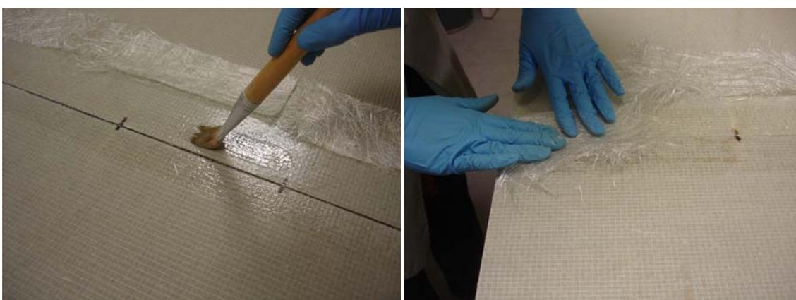
Fig. 39. Aplicando resina EPO 121 sobre las bandas de fibra de vidrio en las juntas del Aerolam.
