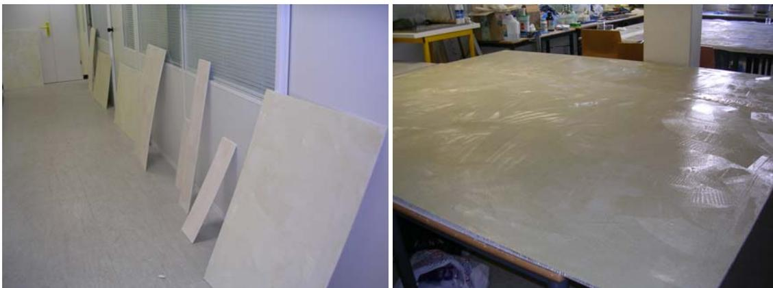
Fig. 40. Adhiriendo el cartón pluma al Aerolam mediante Beva O.F.Gel
