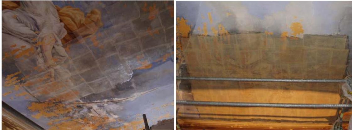
Fig. 23. Telas de arranque colocadas
