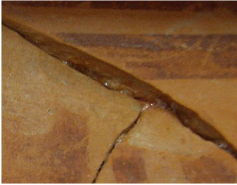
Fig. 81: En la imagen de detalle de esta unión se aprecia cómo parte del adhesivo ha quedado a la vista a causa de un exceso en su aplicación.
