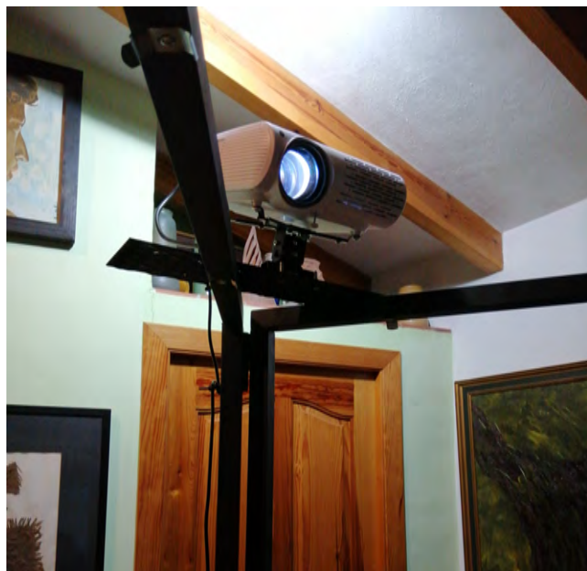
Instalación de los proyectores
