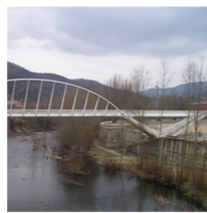
Puente peatonal La Devesa Girona, España, 1991
