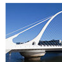
Puente Samuel Beckett Dublin, Irlanda, 2010
