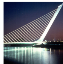
Puente del Alamillo Sevilla, España, 1992
