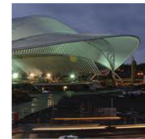
Estación de Oriente Lisboa, Portugal, 1998
