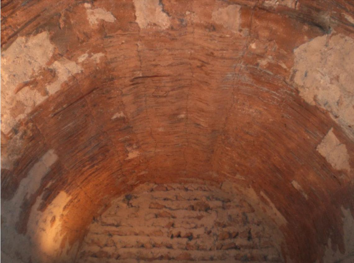
Vista de una de las bóvedas interiores de los niveles más bajos de la torre. Aquí aún se ven en el techo los restos de la costra: revestimiento de mortero de cal y tierra, extendido sobre el manto de cañizo colocado tras el encofrado de la bóveda, (bóveda realizada in situ con tapia calicostrada).
