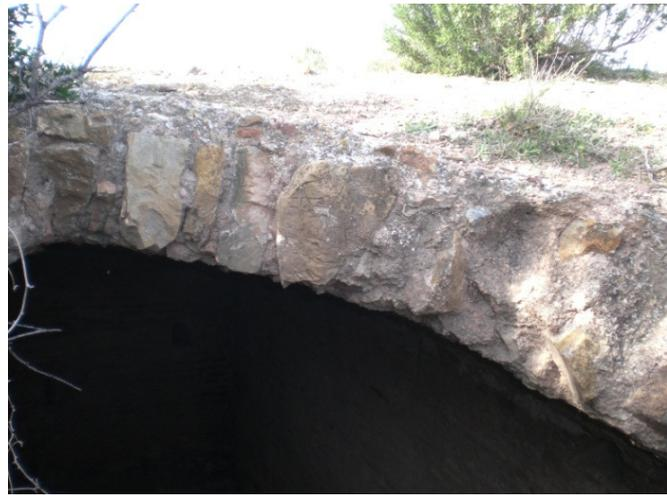
Detalle de la sección de la bóveda de cañón, donde puede verse el aparejo de mampuestos y ripio formando el arco.
