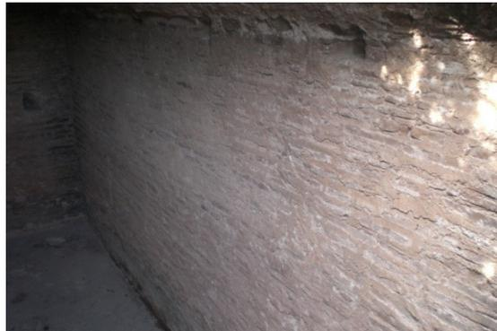
Detalle de la bóveda de cañón de tapia calicostrada y de los muros de aparejo de ladrillo.
