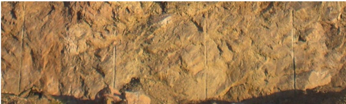
Detalle de las incisiones perpendiculares en la roca para la introducción de dinamita.
