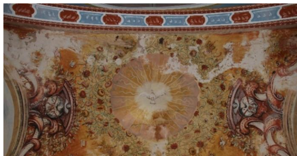
Fig. 28. Estado de la bóveda en febrero de 2019.
