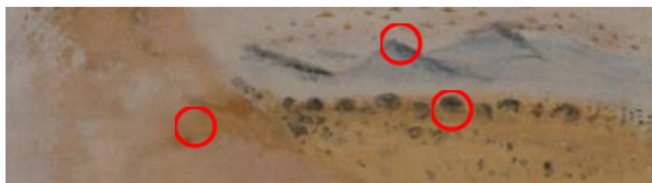
Fig. 35. Ensayos de resistencia a la limpieza ejecutados en la zona izquierda de la bóveda. Las zonas marcadas en rojo representan las catas realizadas.
