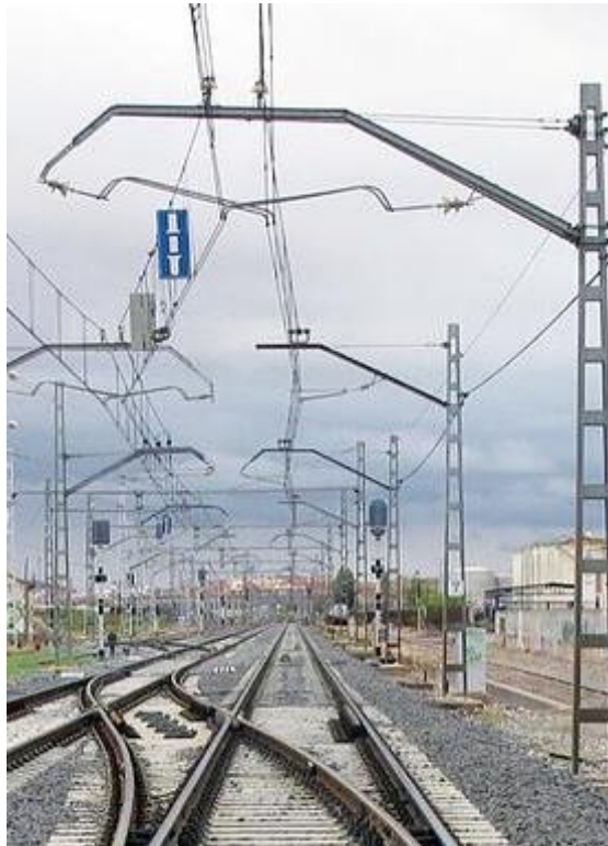
FIGURA 2 DISPOSICIÓN EN ZIG-ZAG DE UNA CATENARIA
