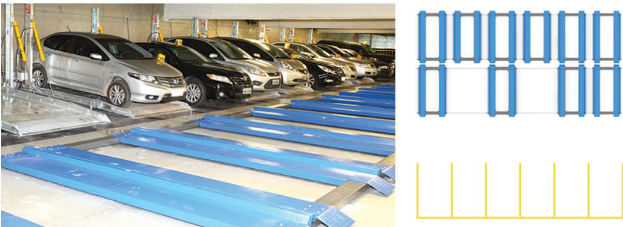
Imagen 9. Sistema de estacionamiento Slide Park
