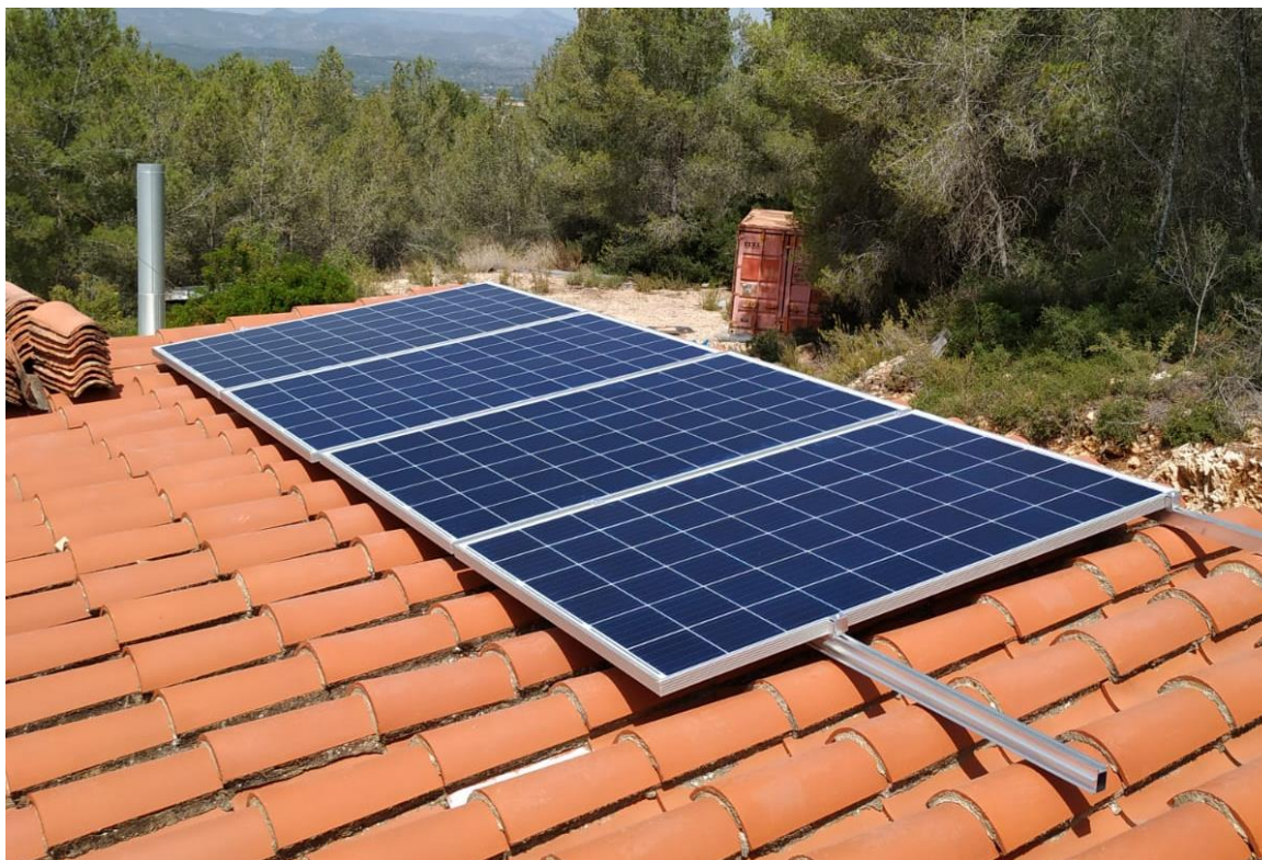
Ilustración 19: Paneles fotovoltaicos colocados en el tejado de la vivienda. (Fuente propia, 2019)
