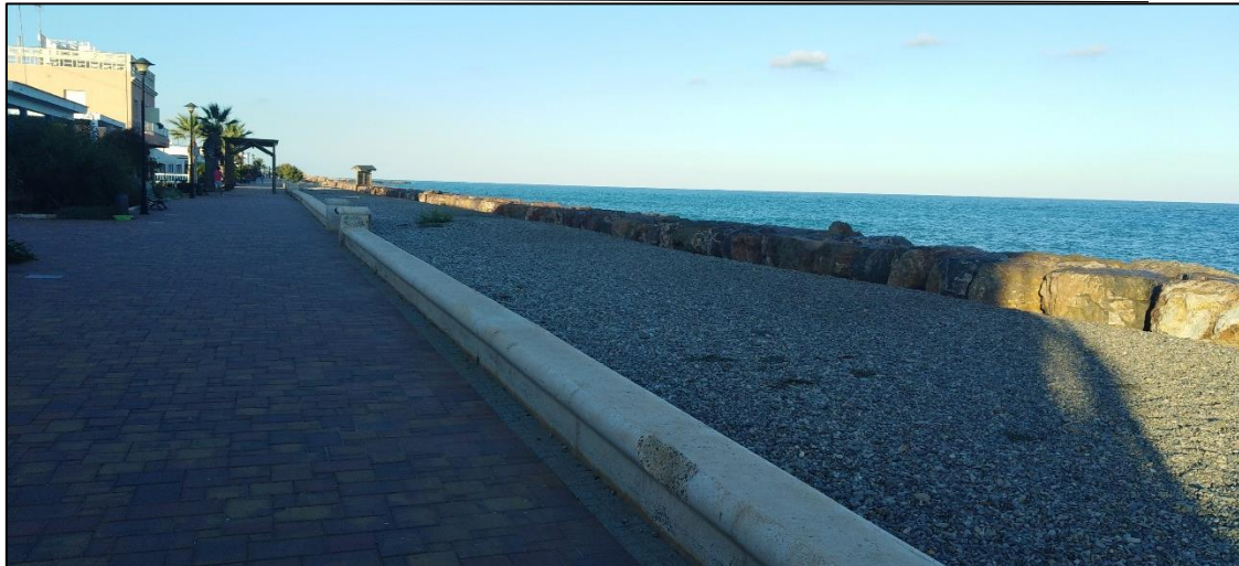
Figura 2. Espigón longitudinal existente en el tramo norte (28/08/2018)
