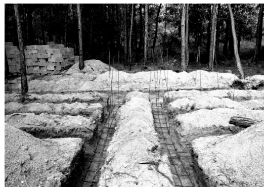
Imagen VI.4.5. Albergue en construcción, comunidad de Los Miche, provincia de Dajabón, República Dominicana, noviembre 2017.
