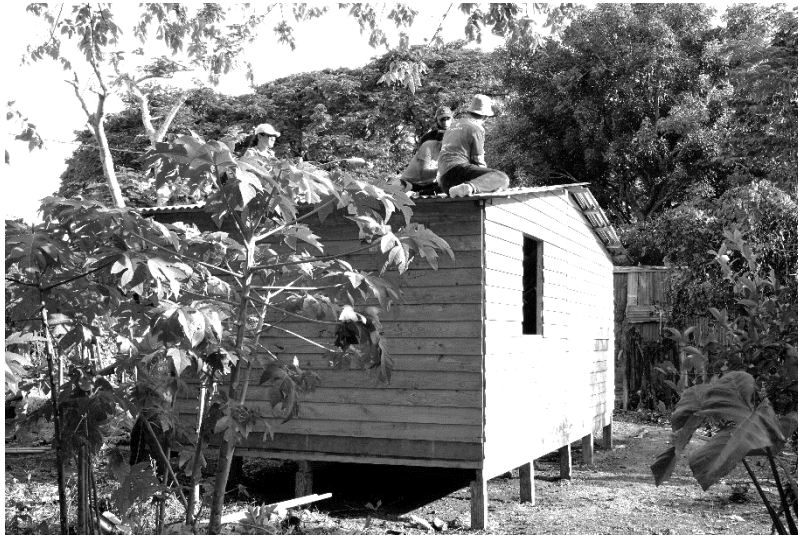
Imagen VI.6.21. Construcción de una vivienda Techo en Higuamo, San Pedro de Macorís, República Dominicana, 2017.
