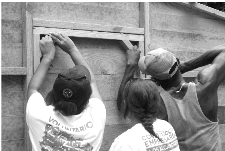
Imagen VII.1. Beneficiarios y voluntarios en la construcción de una vivienda de emergencia de Techo, Los Alcarrizos, República Dominicana, 2017.
