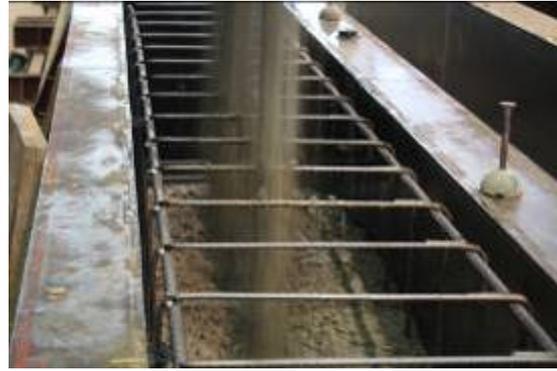
Figura 4. Armadura del pilar mientras se hormigona
