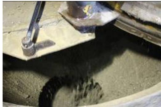
Figura 2. Vertido de la mezcla amasada para el pilar
