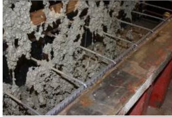
Figura 6. Hormigonado del pilar con NTCs
