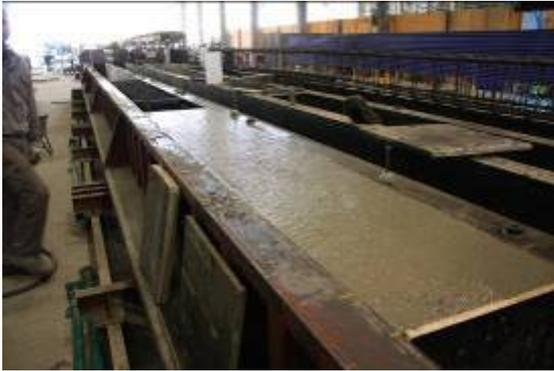
Figura 3. Pilar de hormigón convencional ya hormigonado
