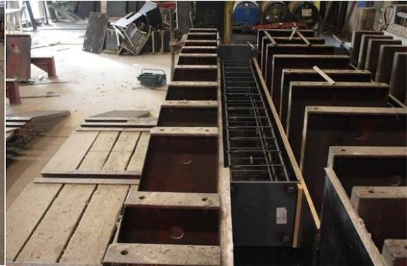
Fig.10 Armadura de pilar en encofrado
