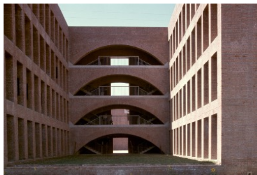
Fig. 143. Patio entre bloques de oficinas
