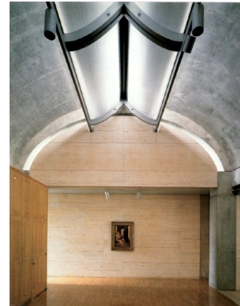
Fig. 124. Interior de la galería. Bóveda cicloide y reflector
