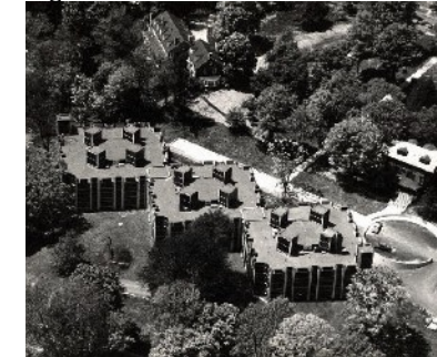
Fig. 54. Vista aérea. Lucernarios
