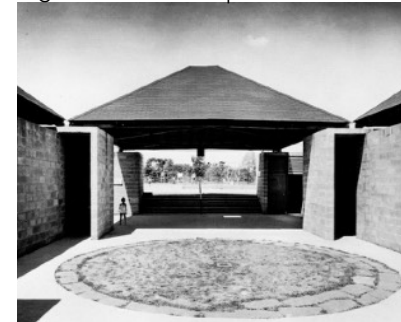
Fig. 59. Vista desde patio central
