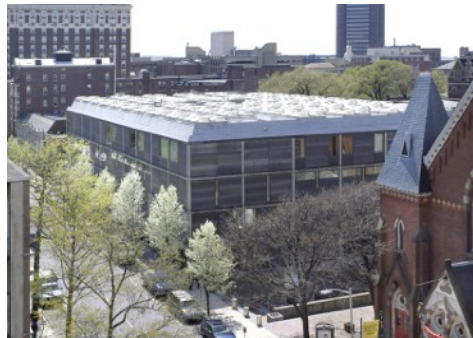
Fig. 133. Centro de Arte británico de Yale. Vista exterior, en la cubierta se observan los lucernarios.
