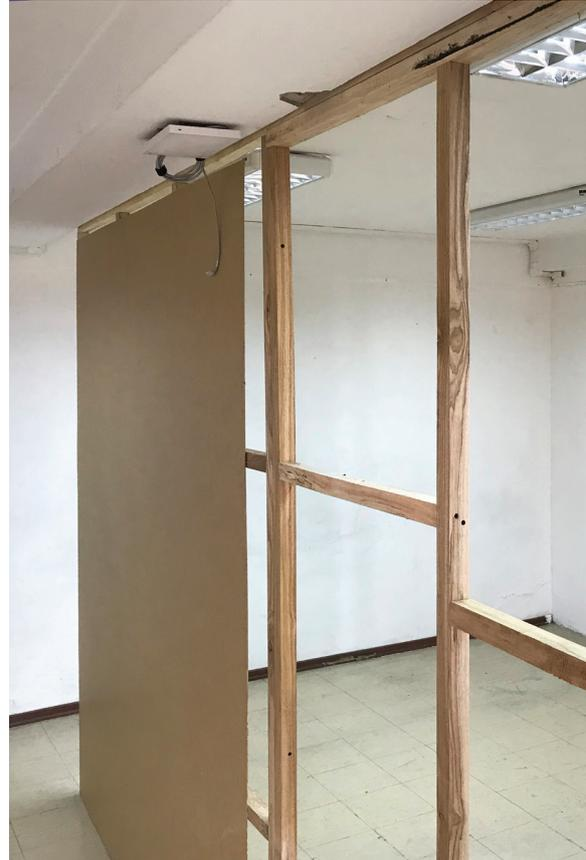
**Fig. 42:** Construcción de la pared divisora de espacio
