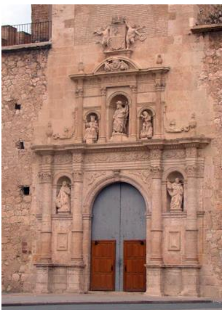
Fig. 5 Portalada exterior, obra de Domènec Gamieta.
